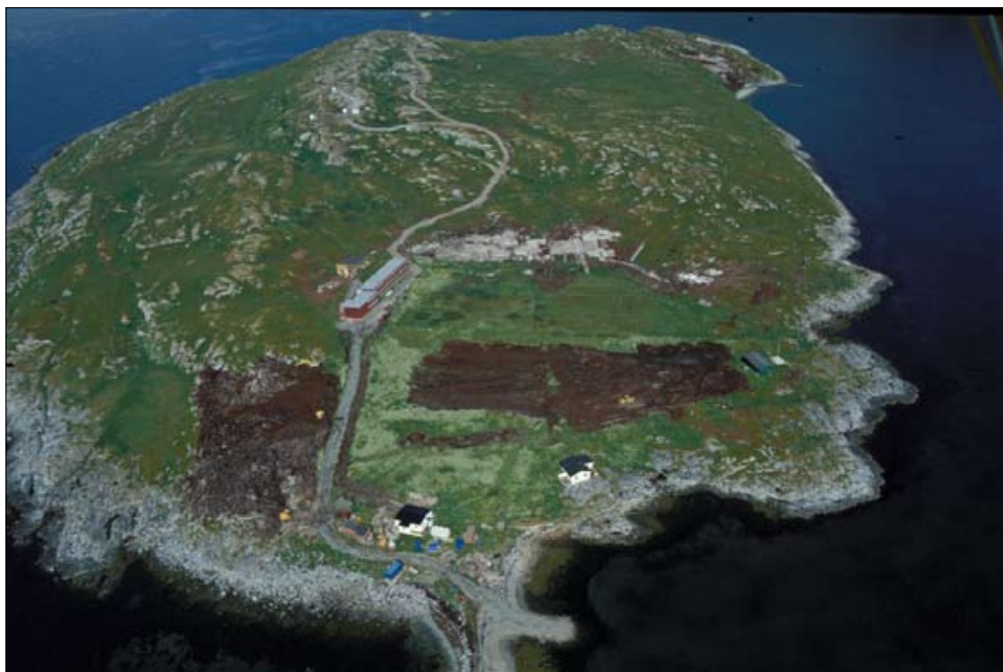
Fig. 4 Melkøya forsommeren 2002. Normannsvika og Kilden midt i bildet, Sundfjæra øverst til høyre. Utbygger har begynt å forflytte masse, området nedenfor Normannsvika/Kilden.
