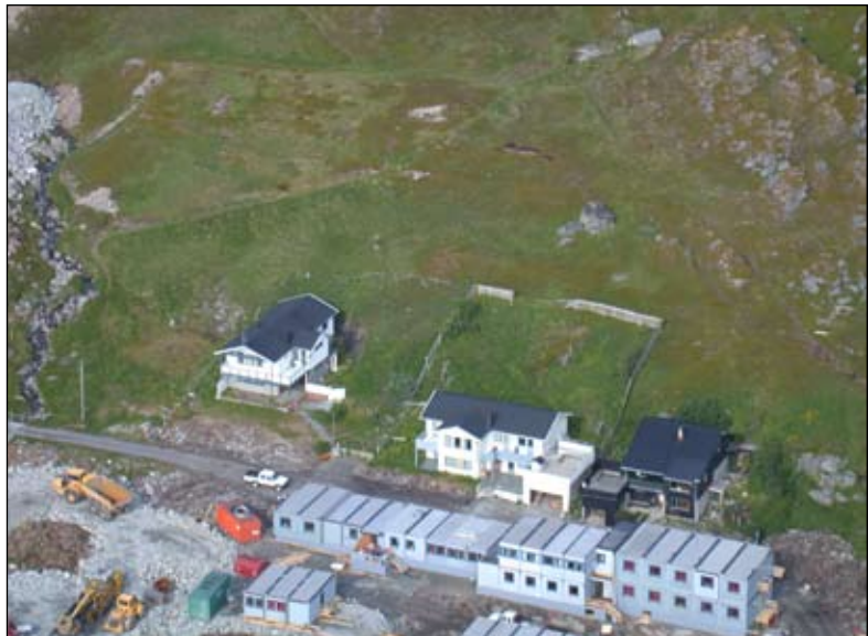
Fig. 5.4 Meland Øvre ligger bak tidligere bebyggelse og brakkeleir anlagt i forbindelse med bygging av tunnel til Melkøya. Foto: Melkøya-prosjektet©Tromsø Museum Universitetsmuseet
