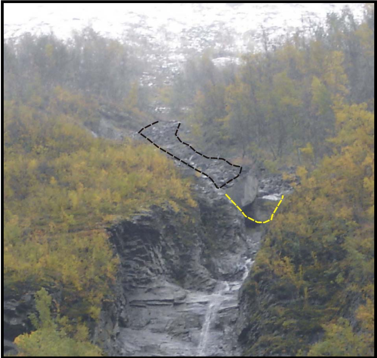
Figur 8-10 Nærbilde av tilførselskanalen. Den gule stiplede linjen markerer 2 veldig store blokker som blokkerer kanalen, mens den svarte stiplede linjen viser stein og blokk rikt materiale som da er blokkert av blokkene markert med gul stiplede linje.
