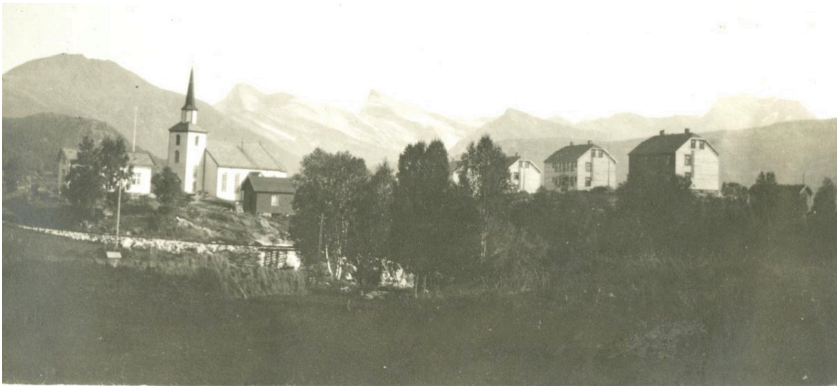
Arbeiderboligene på Kjøpsneshaugen med Hansen-gården og kirka til venstre og huset til Westgård helt til høyre i bildet. I forgrunnen går anleggsveien med skinnene til ”vagga” hvor kalksteinen ble fraktet fra dagbruddet i Pæsa og ned til fabrikken i Pålholla
