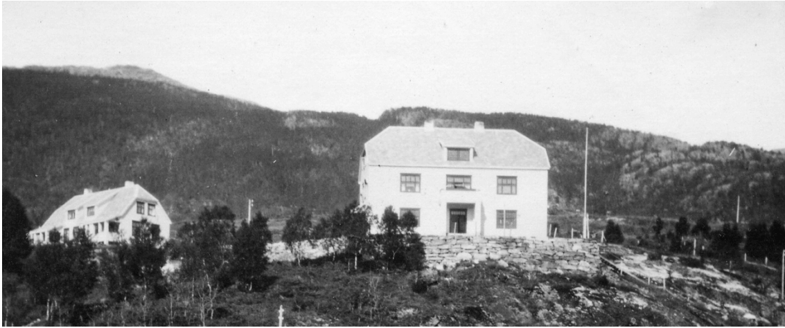
Kontorbygningen med en av ingeniørboligene til venstre, 1. september 1920.
