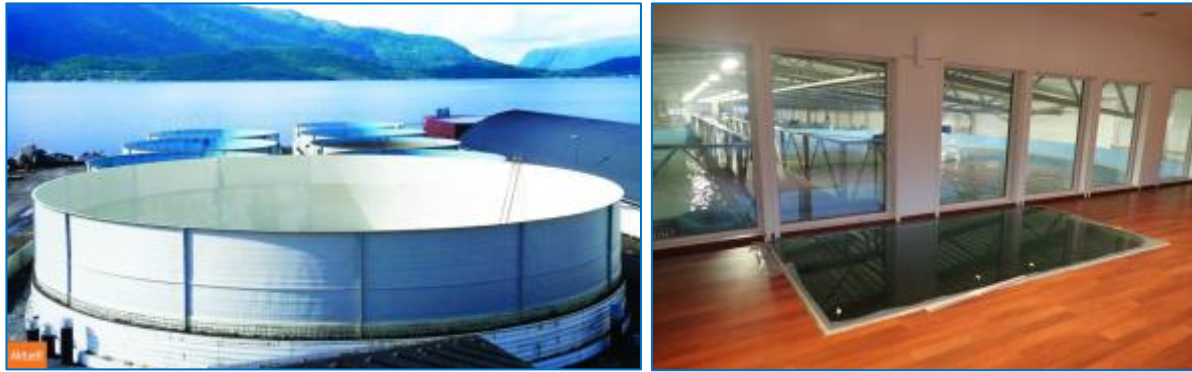
Figur 1 Produksjonsanlegget før det ble overbygd (Kyst, 2016a) og kontrollrommet med utsikt over produksjonshallen.
