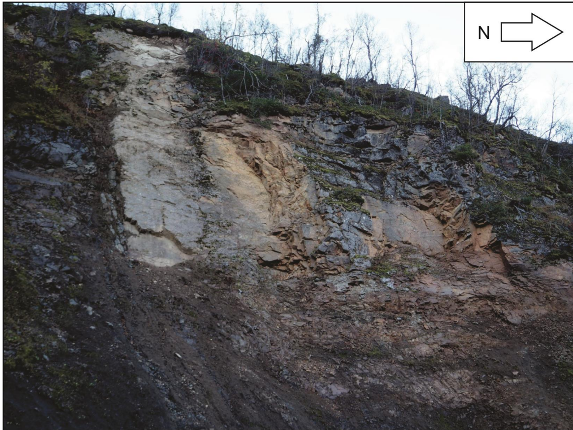
Figur 43: Vestlig dalside med steile NNØ-SSV strykende bruddplan. Bruddflatene er godt synlige og faller parallelt med dalsiden.
