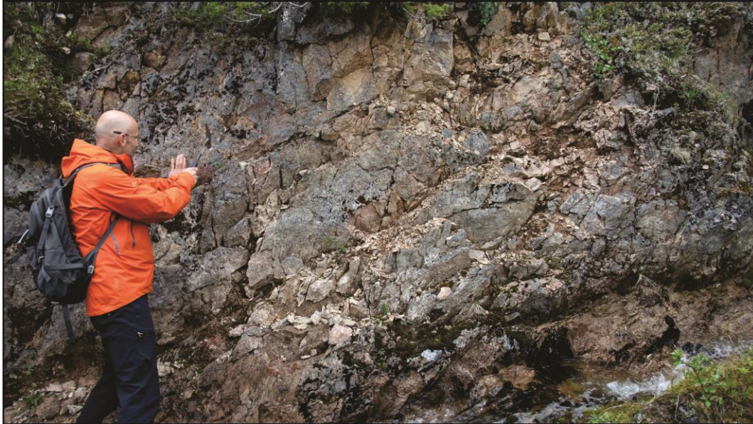
Figur 38: Sterkt oppknust foliert granitt/granittisk gneis i et mindre elveløp lokalisert mellom Tverrelva og Kråfjellelva i Norddalen.
