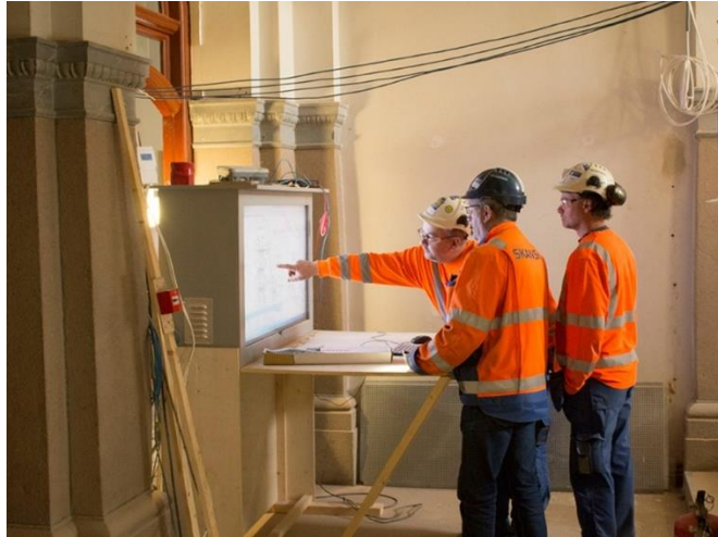
Figur 7.1: BIM-kiosk som faglig møteplass på byggeplassen (4B Arkitekter, 2015).
