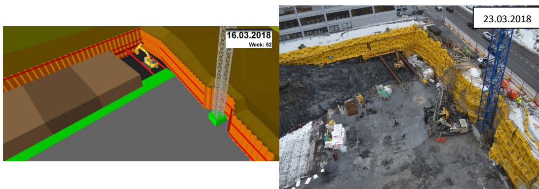
Figur 6.6: Sammenligning av 4D-modell og byggeplass.
