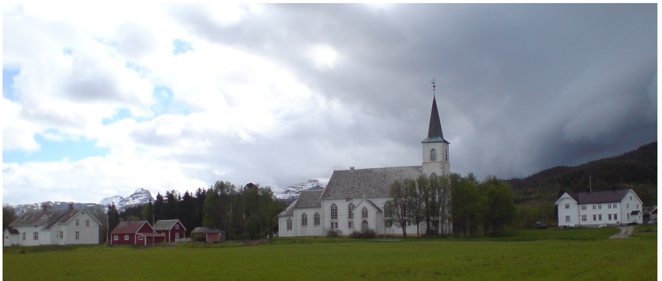
figur 9 Ibestad kirke i dag. Gårdshaugsområdet ligger bak kirken i syd. Dagens prestegård ligger til venstre i bildet
