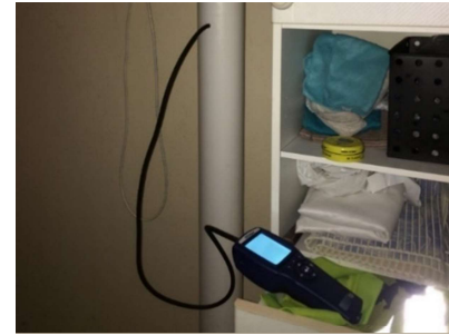
Figur 5.2.1-2. Måling av trykk i kanal.
