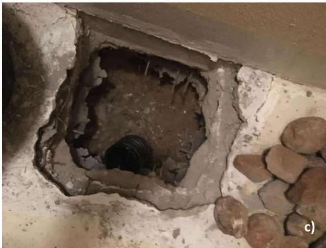
Figur 5.1.1-2. Riving av gammelt sugepunkt. Plassering vist på plantegning i figur 4.4.1-1, a) boring og meisling for å åpne hullet; b) hull åpnet; c) stein og masser fjernet; d) flexrør fra den gamle radonbrønnen.
