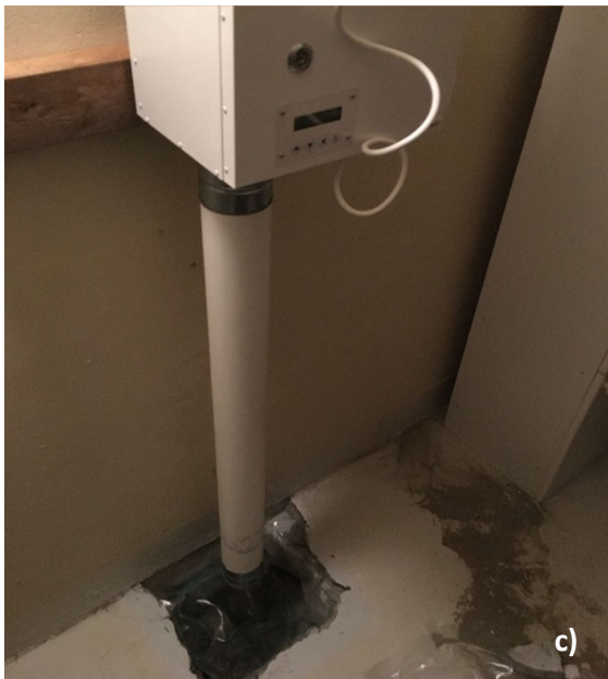
Figur 5.1.1-3. Installering av ny radonbrønn, a) den nye brønnen klar for det åpne hullet; b) den nye brønnen påkoblet kanalsystemet; c) den nye viften og brønnen koblet på; d) hull gjenstøpt og fuget.
