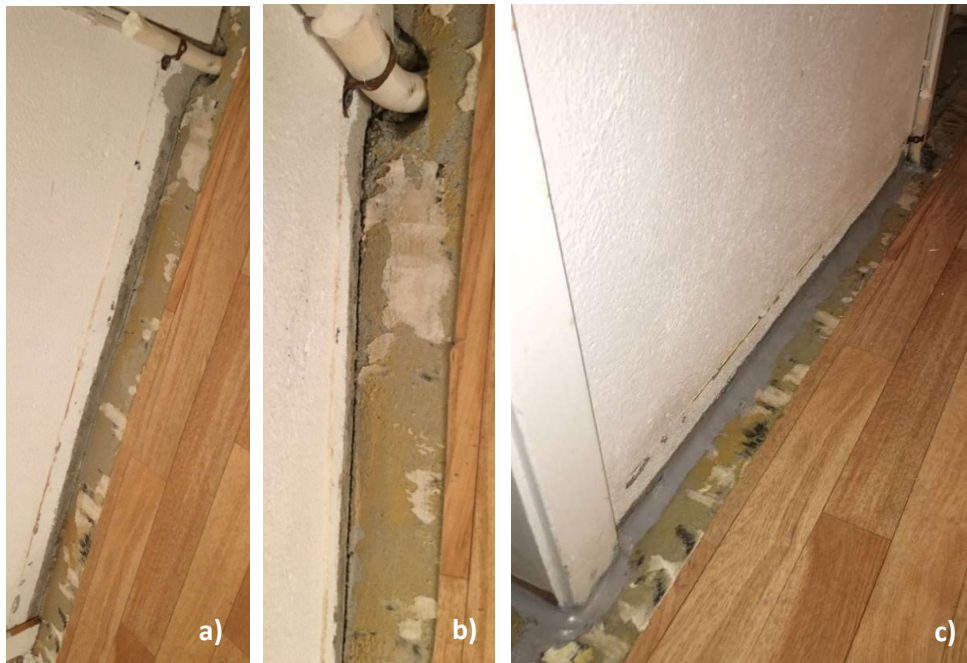
Figur 5.1.2-4. Tetting i overgang vegg/gulv. Plassering vist på tegning i figur 4.3.2-1, a) belegg revet av; b) store krympesprekker og utettheter; c) ferdig fuget.
