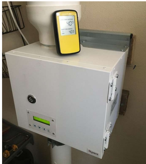
Figur 5.2.1-8. Radonmåling i etterkant av bytte av radonbrønn.
