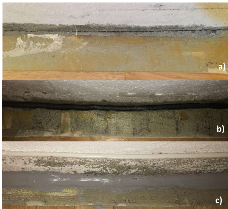
Figur 5.1.2-5. Tetting i overgang vegg/gulv. Plassering vist på tegning i figur 4.3.2-1, a) belegg revet av, krympesprekk synes; b) meislet og bunnfyllingslist plassert; c) fuget over.
