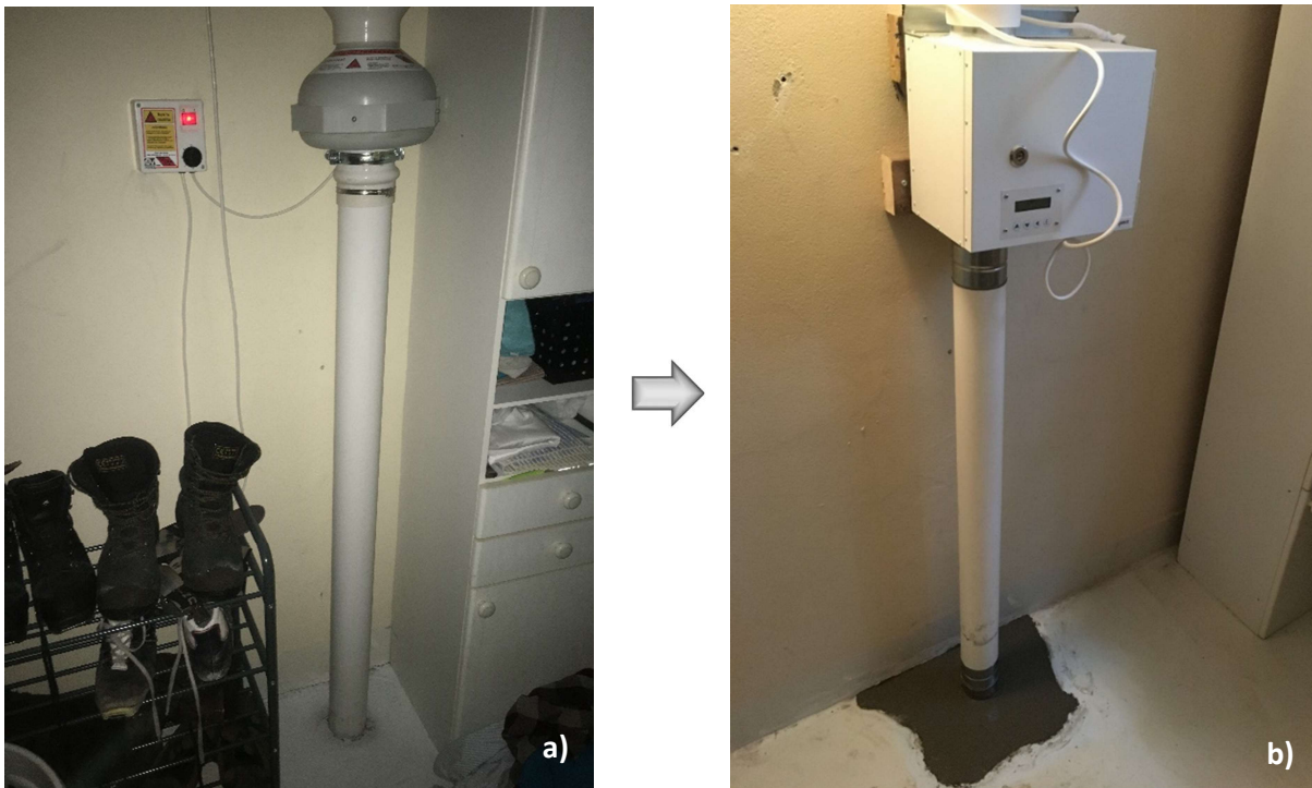
Figur 5.1.1-1. Installasjon av ny radonbrønn, a) den gamle viften og brønnen; b) den nye viften og brønnen.
