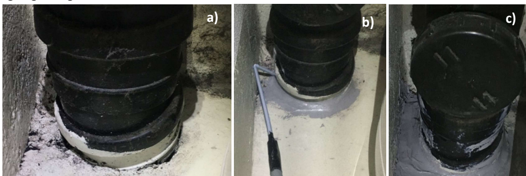
Figur 5.1.2-11. Tetting rundt gjennomføring i gulvet i vaskekjeller, a) før fuging; b) under fuging; c) fuget.
