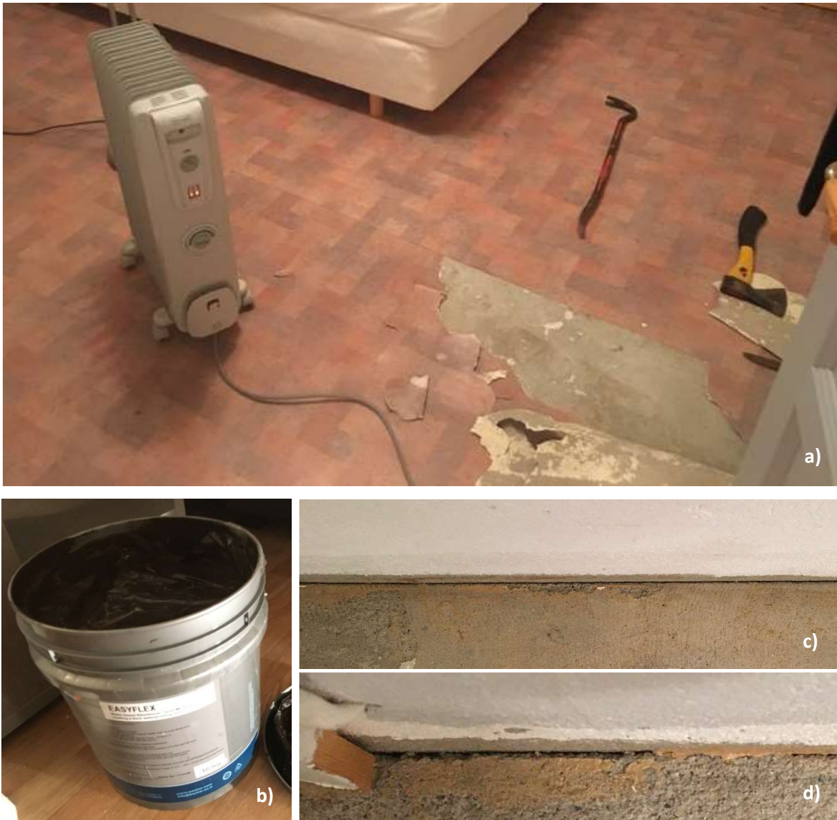
Figur 5.1.2-7. Klargjøring for tetting av soverom 1. Plassering vist på plantegning i figur 4.3.2-1, a) riving av gulvbelegg påbegynt; b) Easyflex smøremembran; c); d) krympesprekker langs overgang vegg/gulv.
