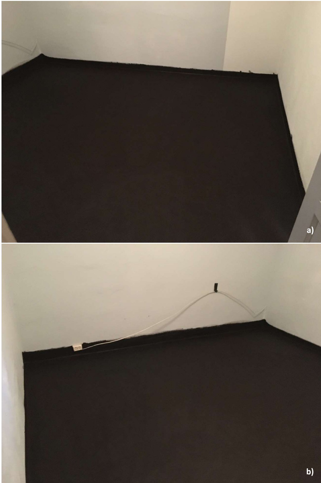
Figur 5.1.2-9. Soverom 1 etter påsmurt membran.
