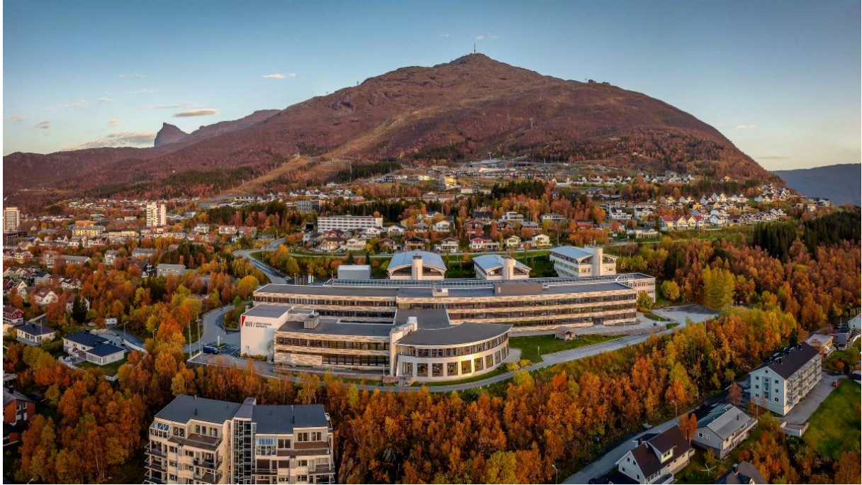
Figur 4-2: UiT Campus Narvik sett fra nordvest etter oppgradering/ rehabilitering [45].
