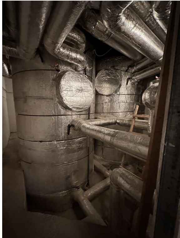
Figur 25: Store buffertanker med et totalt akkumuleringsvolum på 50 000 liter
