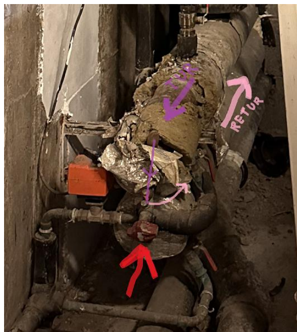
Figur 26: Rød pil viser strupeventilen som regulerer gjennomstrømningen i samlestockene.
