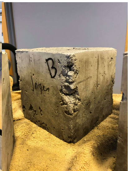
Bilde 6 Feil/dårlig komprimert
