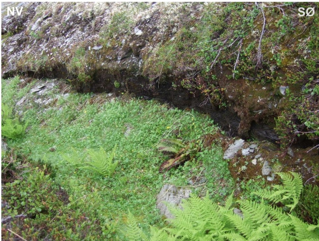
Figur 4.57: Forsenkning i terrenget, hvor revnen i jordsmonnet antyder relativt nylig bevegelse i terrasse i midtre deler av skredet.
