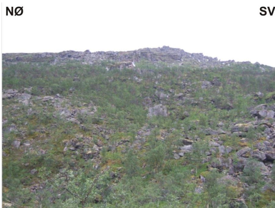
Figur 4.5: Bratt skrent i nedre del av skredet som er dekket av løse blokker, fordi store deler av berggrunnen er utrast.
