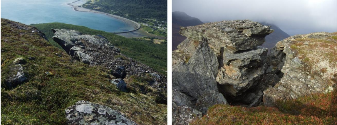
Figur. 4.34: Skrentkanter i midtre del av skredet, hvor delvis løse blokker er adskilt fra omliggende berggrunn av steile sprekker.
