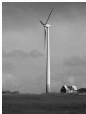
Figur 9.18: Horisontalakslet vindturbin med en effekt på 2 MW
