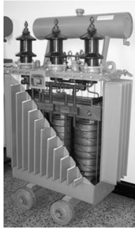
Figur 5.35: Gjennomskåret trefasetransformator
