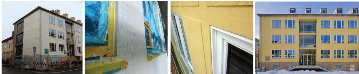
Figur 17 Gjennomføring av utvendig etterisolering av yttervegg med "aerogel" (Ganobjak et al., 2023)
