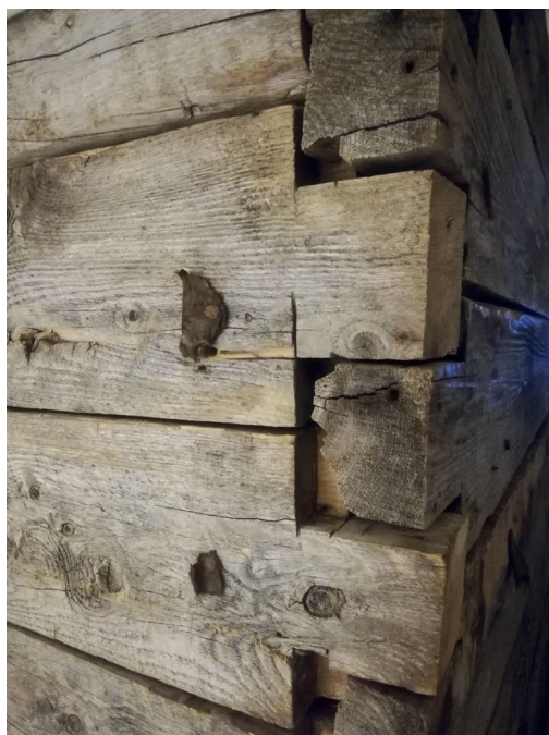
Tømmerveggen som rekvisitt i Varangerhusutstillingen ga muligheter for å undersøke «kvenknuter» tett på. Foto: Gyrid Øyen.
