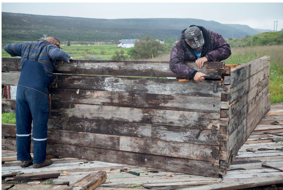
Undersøkelse og montering av tømmeret som lå under en presenning. Foto: Pirjo Nykänen.
