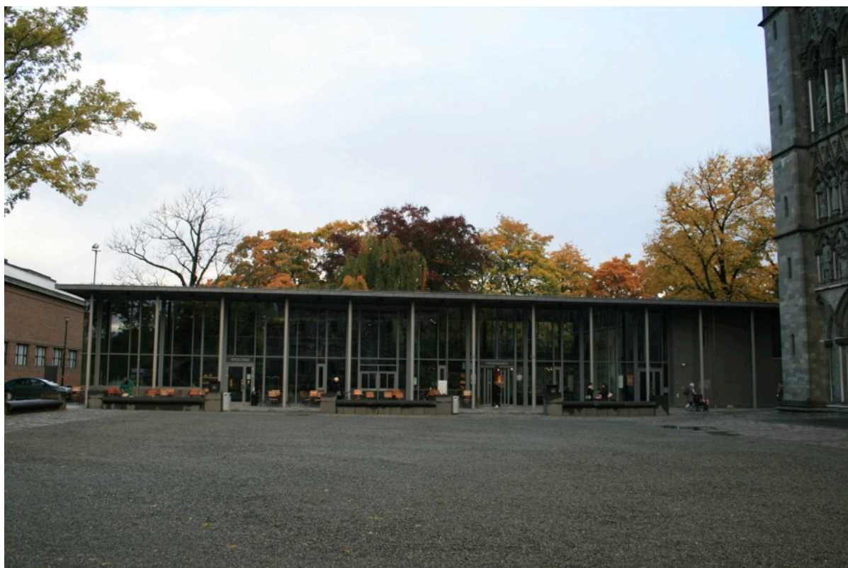
Figur 7. Besøkssenteret sett fra sørsiden av Vestfrontplassen med Nidarosdomen til høyre.
