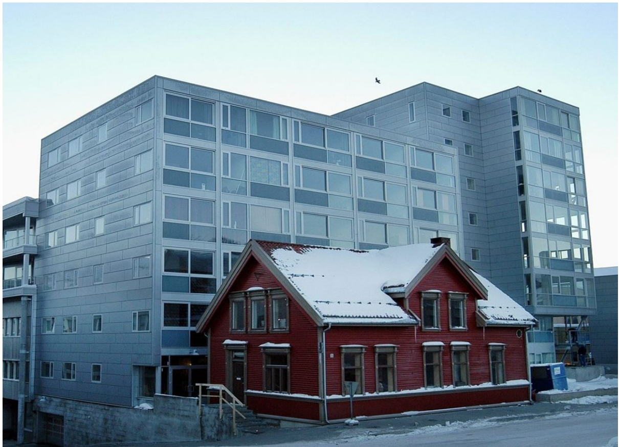
Figur 22. Sentrum Terrasse, Vestregata 25, Tromsø, ble utformet av John Kristoffersen, Arkitektkontor AS, og sto ferdig 2002.
