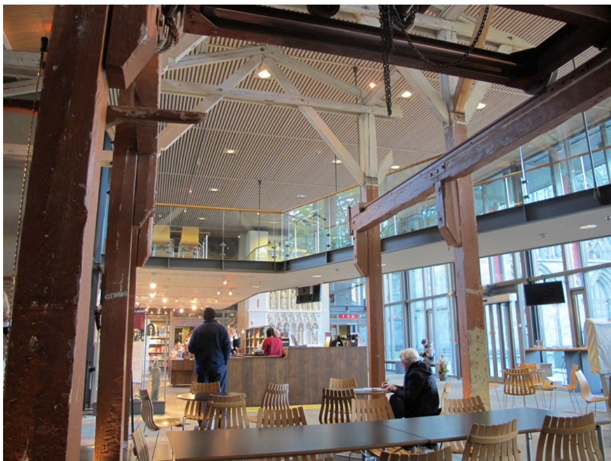
Figur 9. Innvendig i besøksenteret, det store rommet er delt diagonalt av galleriet som blir båret av stålstag, og en del av det gamle bjelkelaget fra steinhuggerhallen i forgrunnen.
