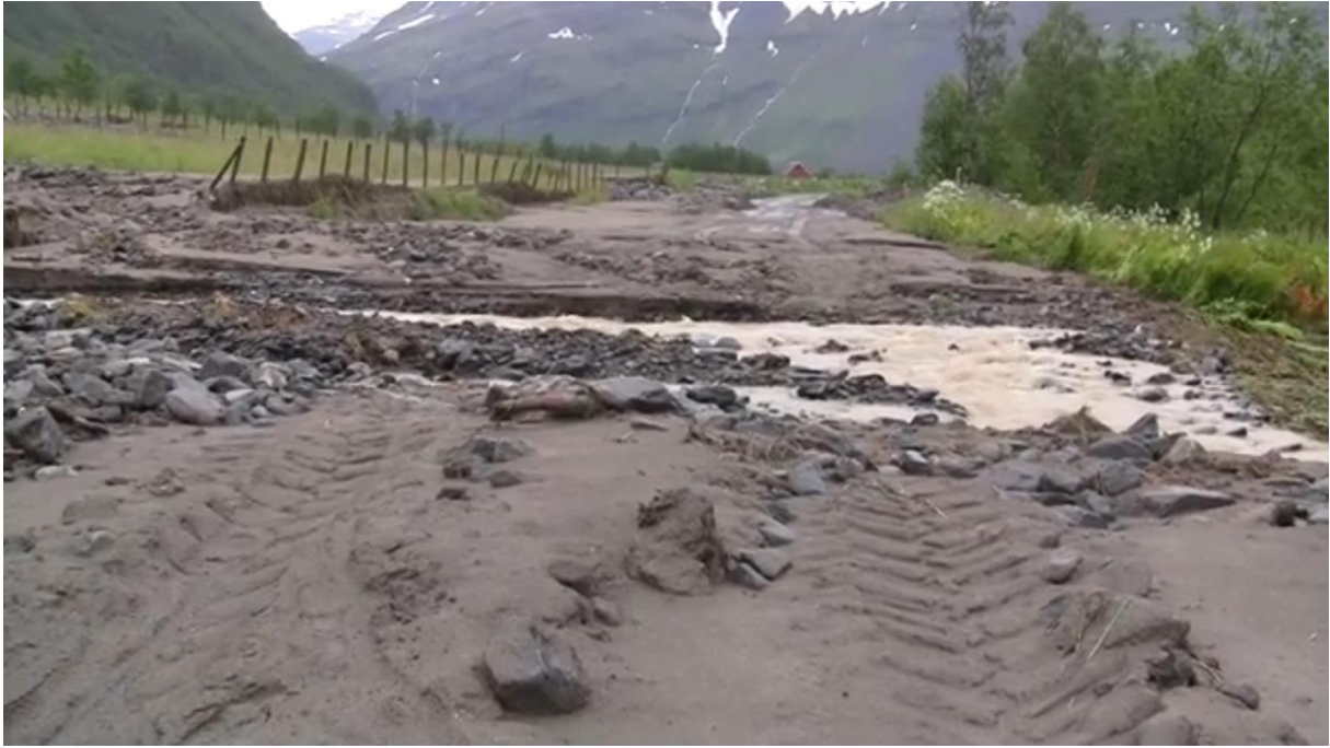
Figur 4-43. Skredmassane gjekk over vegbanen. Utdrags-bilete frå Figenschau (2012).
