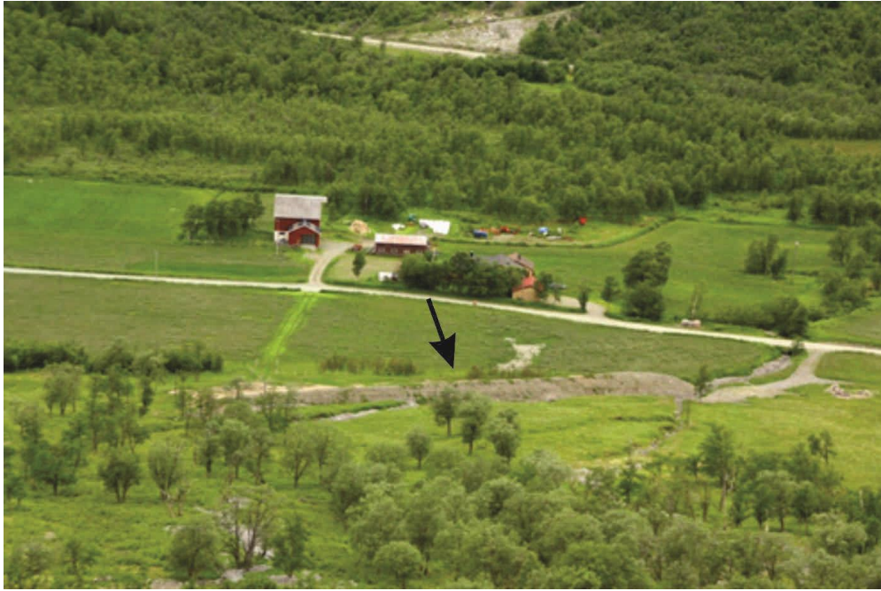
Figur 4-31. Ein skredvoll er bygd for å beskytta gardshusa til garden Broderstad. Foto teke 27.6.2013.
