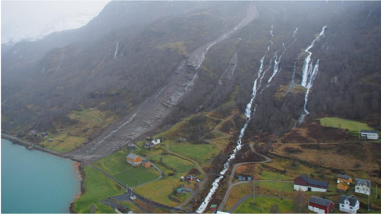
Figur 1-2. Skred og flaum i Olderdalen ved Yri, Sogn og Fjordane, 16.11.2013. Foto: Jan Helge Aalbu, NRK.
