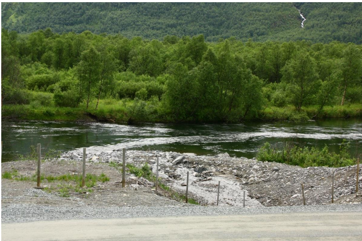
Figur 4-15. Debris-flowen rakk over vegen og enda i Signaldalselva. Avsetjingane som dekkja vegbanen og dei nærliggjande områda er rydda bort. Foto teke 25.6.2013.
