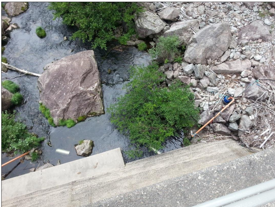
Åleledere (til venstre og høyre i bildet) ved dammen ved utløpet av Lundevatnet (oppvandringsrør laget av PVC-drensrør og fangstkammer bestående av blå plastdunk). Plasseringen av to åleledere for fangst av ål ved dammen vises også i bildet. Bildet er tatt fra dammen og rett ned i elva. Foto Rolf Midtbø.
