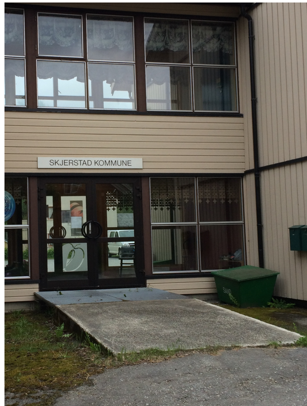
Bilde 7.2: Den tidligere inngangen til Skjerstad kommunes administrasjon kan fortsatt ses på baksiden av kommunehuset. Foto: Sindre Torp.
