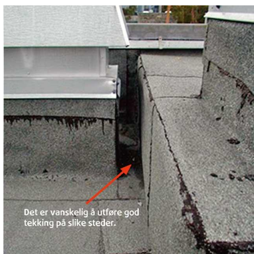
Figur 33: Eksempel på uheldig utforming av taket hvor gjennomføringer er plassert nært hverandre (SINTEF, 2012).
