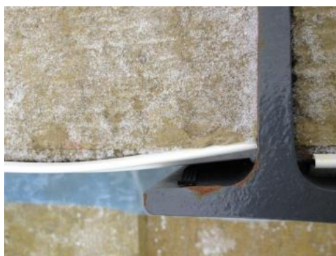
Figur 51: Bildet viser parapeten sett ovenfra med bærende stålprofil (Noreng, 2015).
