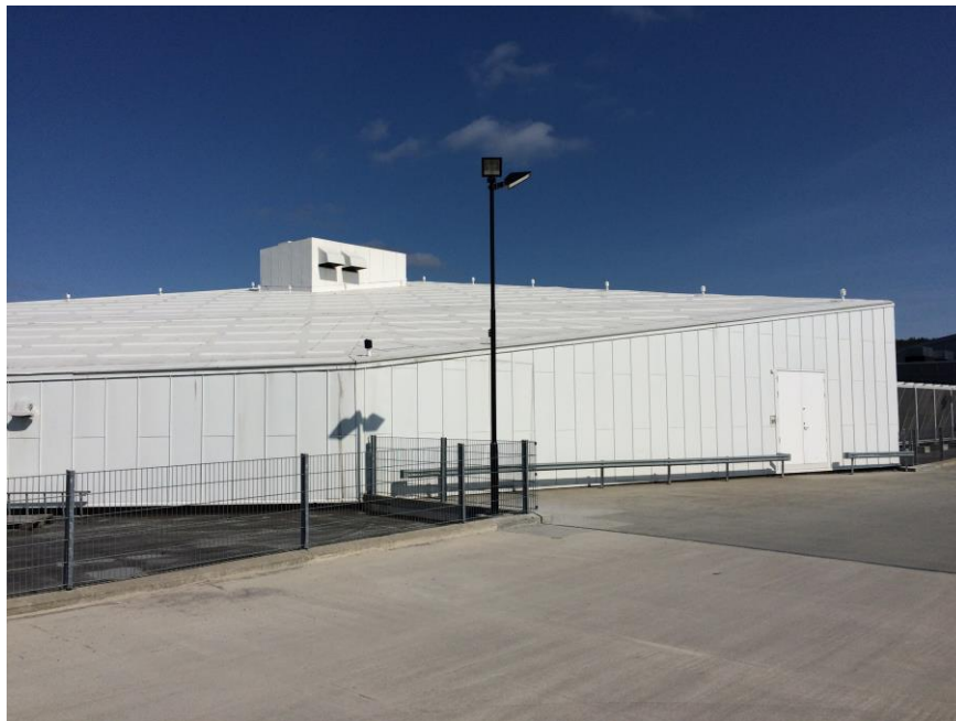
Figur 66: Teknisk rom 2 (Foto: Martin Jonassen Fjelde, 2016)
