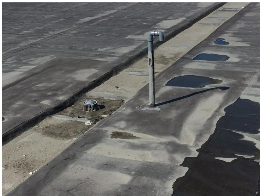
Figur 60: Rør for lufting av takkonstruksjonen ved sluk (Foto: Martin Jonassen Fjelde, 2016)
