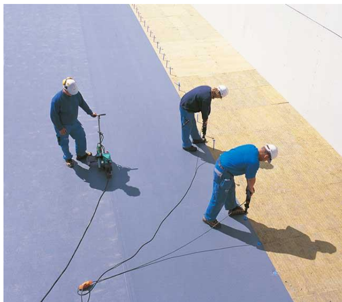
Figur 41: Illustrasjonsbilde av taktekking med takfolie (Protan, 2016).
