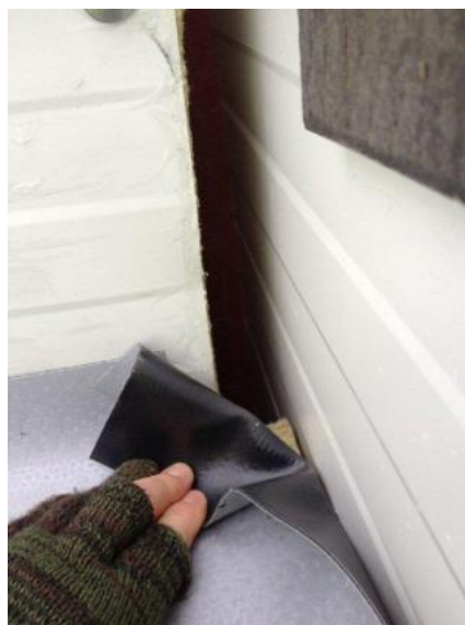
Figur 49: Bildet viser en stor spalt ved sammenføring i et ytterhjørne (Noreng, 2015).
