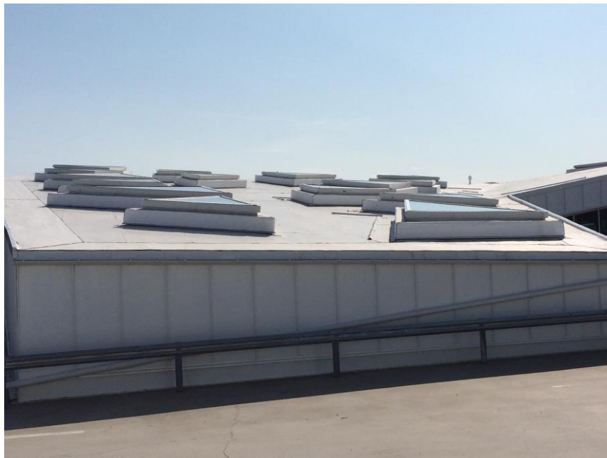
Figur 61: Bilde av torg 13 etter tiltak er gjort (Foto: Martin Jonassen Fjelde)
