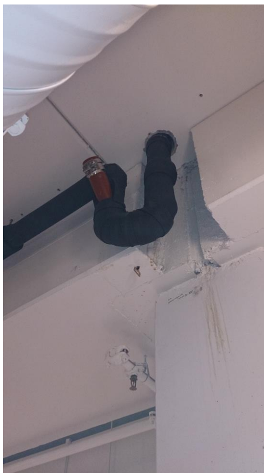
Figur 59: Vannlås montert på rør til nedløp (Foto: Privat, 2015)
