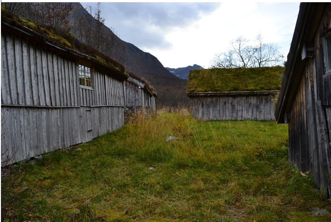
Figur 12: Råket mellom seterbuene og fjøsene. På buene til venstre kan man se de to etasjene og døra i underetasjen. Foto: Kjersti G. Krogsæter
