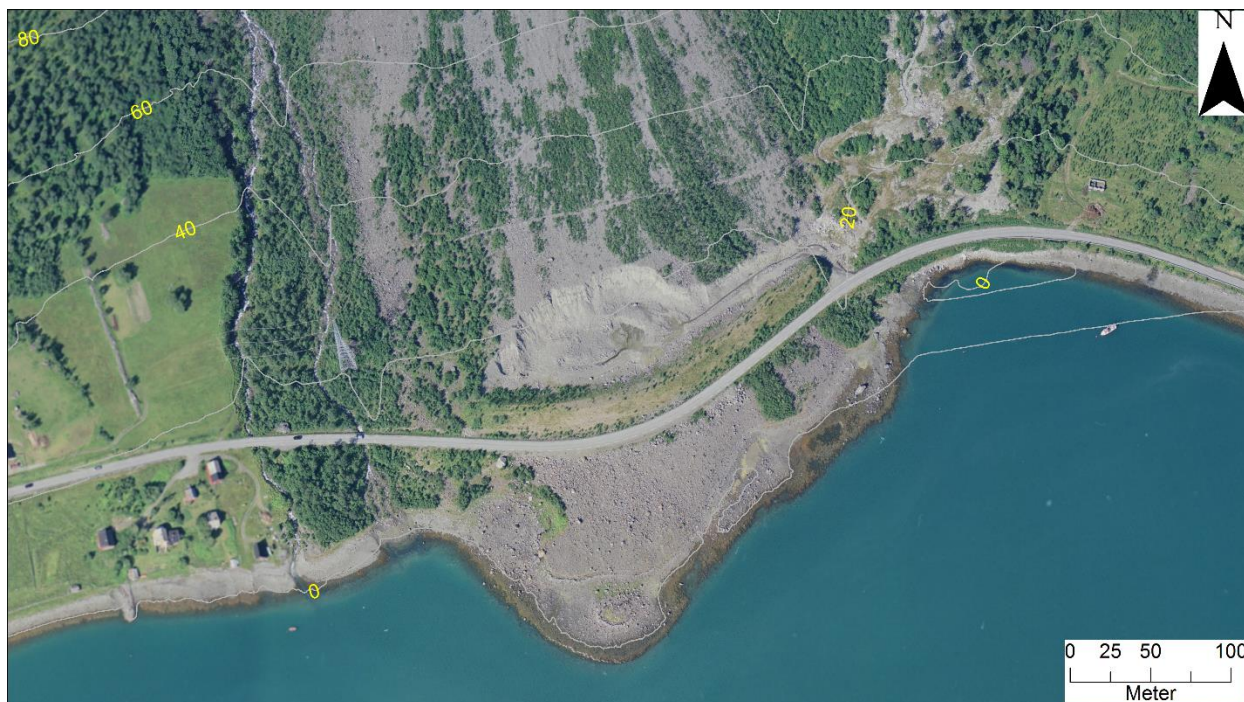
Figur 66: Skredvoll som skredsikringstiltak ved Storurda. Flyfoto fra 2004.
