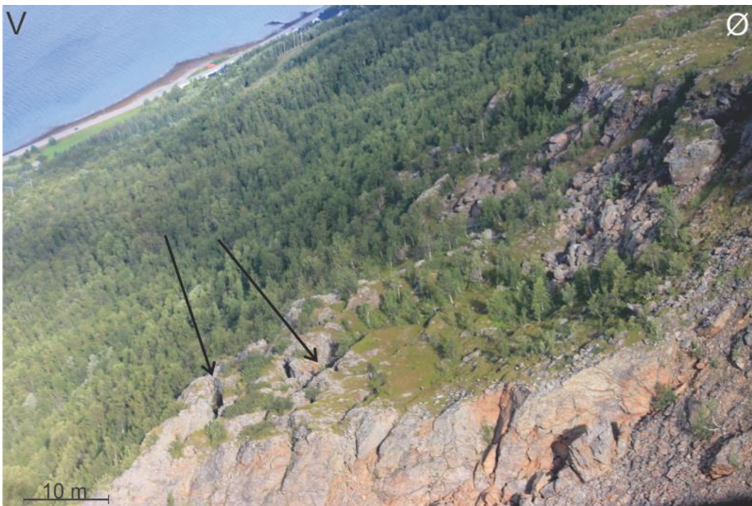
Figur 80: Ustabil fjellparti ved Skredan. Vest-øst strykande sprekkesett avgrenset partiet i en skrent i bunn av bildet. Sprekkesett i NØ-SV og NV-SØ retning har åpnet flere store sprekker (pilar) i den ustabile blokken. Foto: Eirik Bjørklid.
