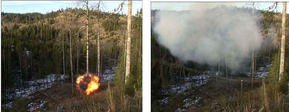
Figur 11 Fra arbeidet med å lage høystubber av ospetrær ved hjelp av detonerende lunte, høst 2001. Foto: Torgeir Beck Lande
