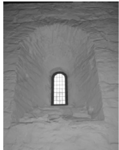
Det øststligste vinduet på nordveggen i skipet innvendig. Foto: K. Kristoffersen.
