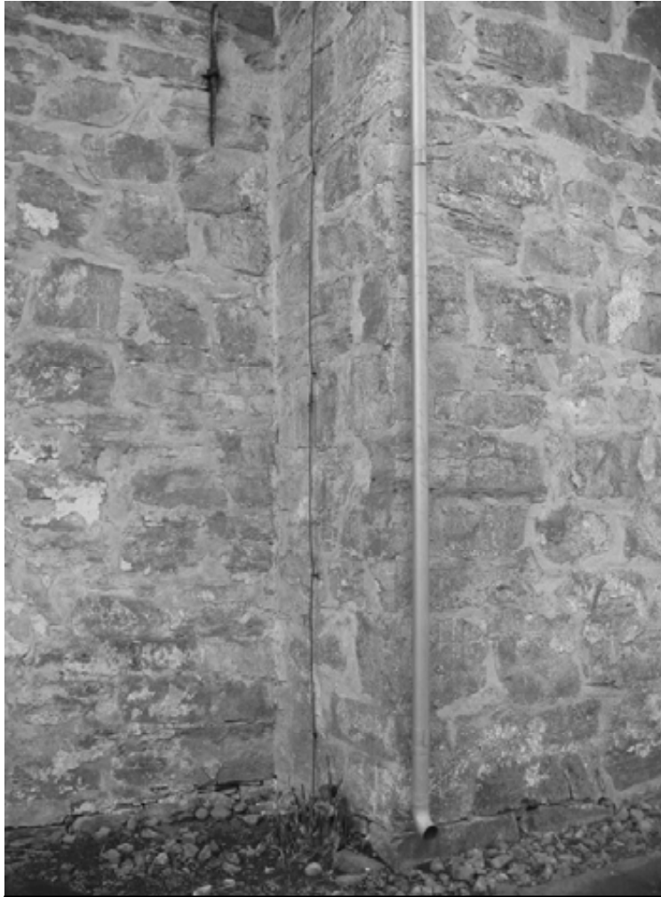
Overgangen mellom skip og kor, altså vestre deler av nordveggen i koret, østveggen i skipet på nordsiden og østre deler av nordveggen i skipet. Foto: K. Kristoffersen.
