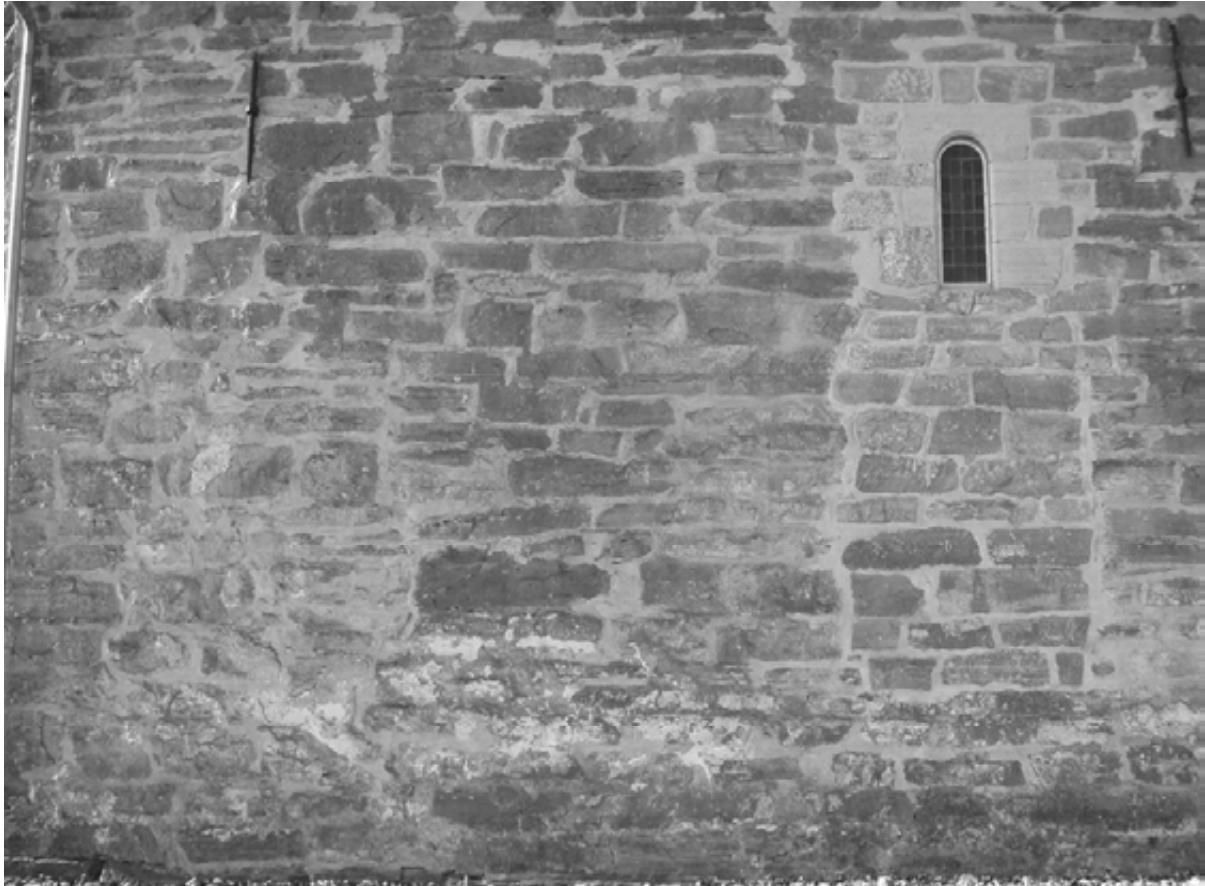
Østre deler av nordveggen i skipet. Foto: K. Kristoffersen.
