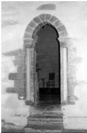
Figur 3.3. Sørportalen i koret mot nord. Foto: K. Kristoffersen.
