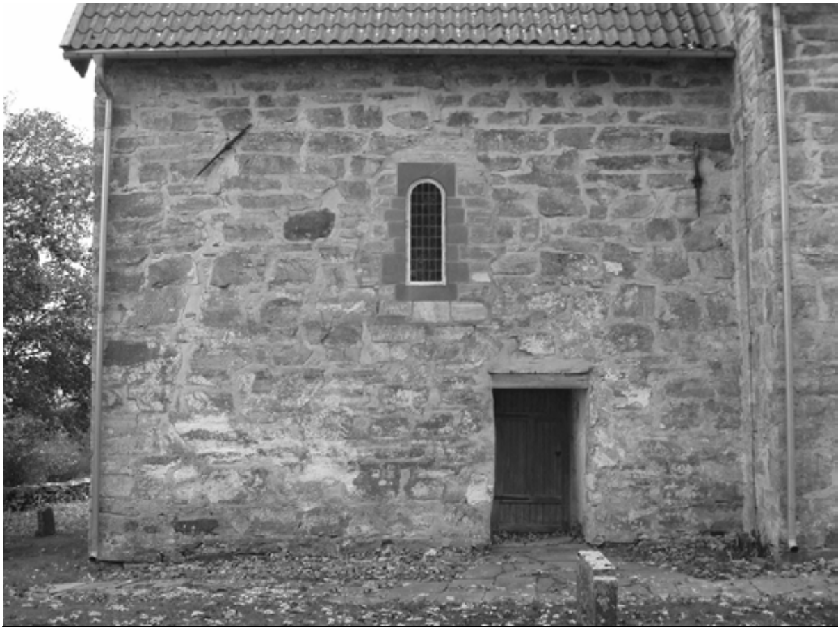
Nordveggen i koret og hjørnet mellom skip og kor. Foto: K. Kristoffersen.
