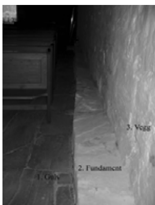
Figur 7.2. Gulv, fundament og vegg mot vest langs innsiden av nordveggen i skipet. Foto: K. Kristoffersen.
