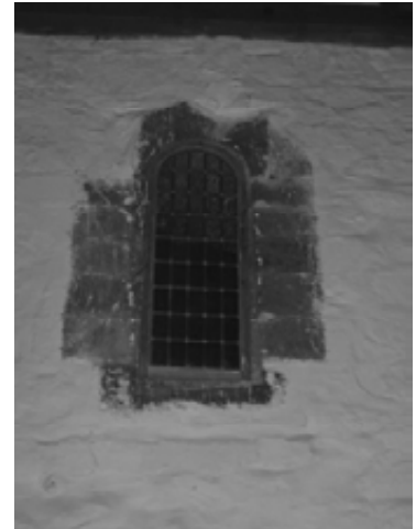
Sørvinduet i koret på det som ville ha vært utsiden før sakristiet ble bygd. Dette vinduet er plassert øst for portalen og høyt oppe på veggen. Foto: K. Kristoffersen.
