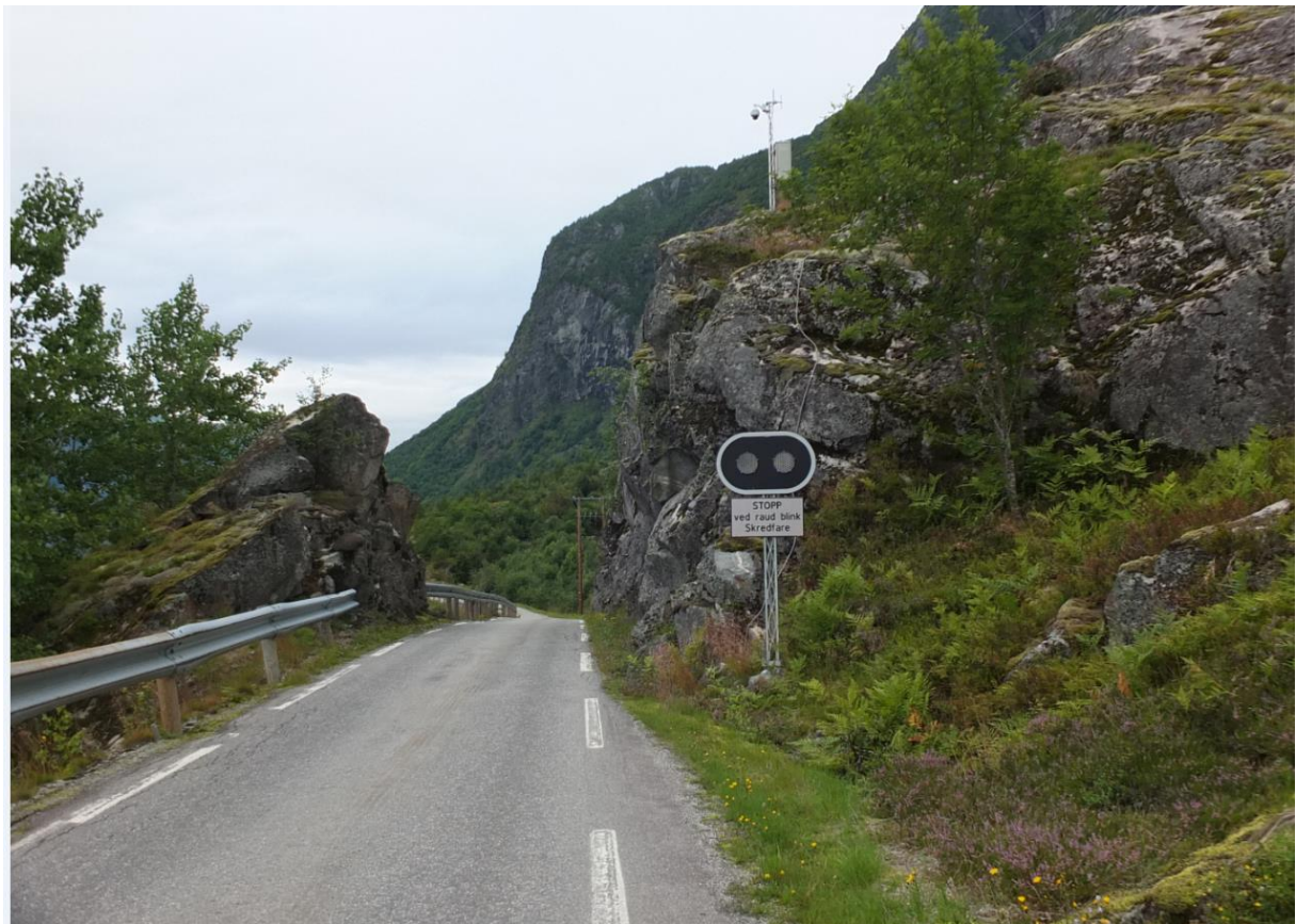
Figur 27. Kamera for verifisering av skredmasser på veg er plassert på toppen av vegskjæringen til høyre. Lysskilt for varsling av trafikanter på høyre side av vegen. Bildet er tatt på befaring av forfatteren sommeren 2016.
