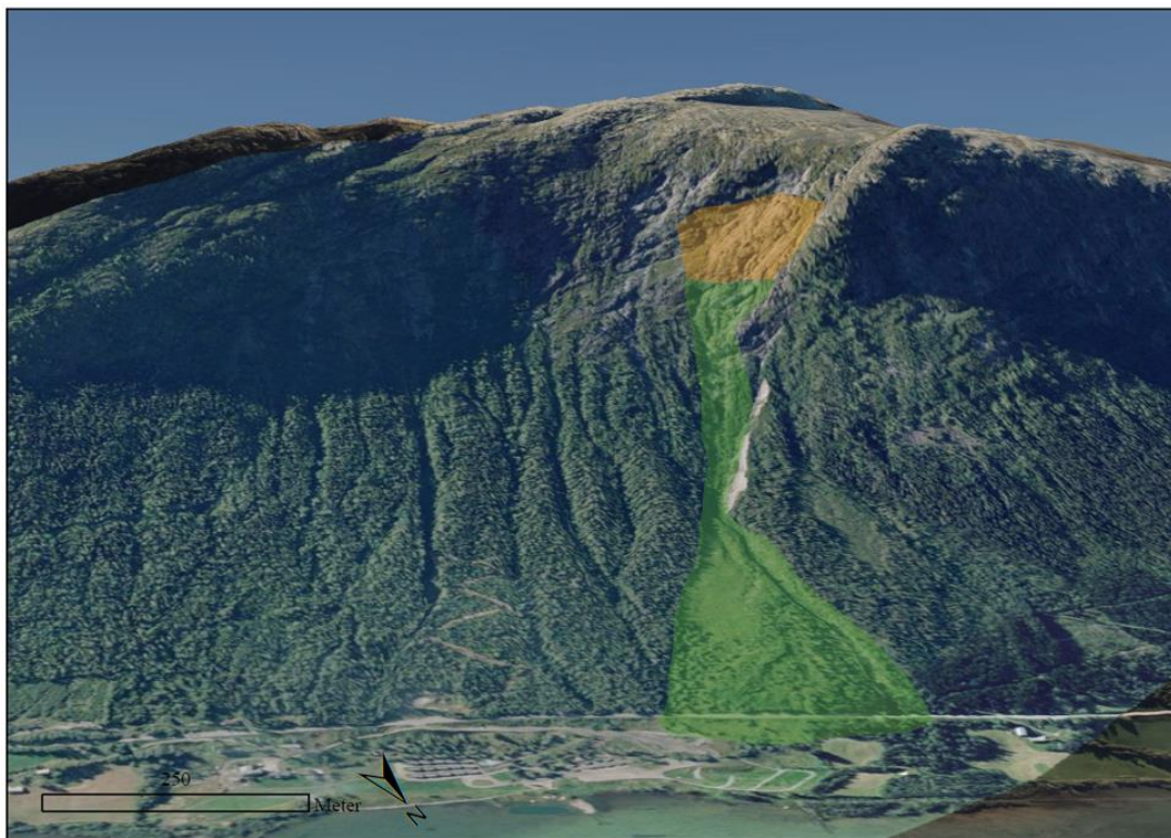
Figur 19. Skredløpet Knutstugugrove. Løsneområdet er markert i oransje og skredløpet er markert i grønt. En øvre langsgående rygg langs løsneområdet gjør at det ligger i le og en langsgående løsmasserygg i utløpsområdet kanalisere skredløpet.
