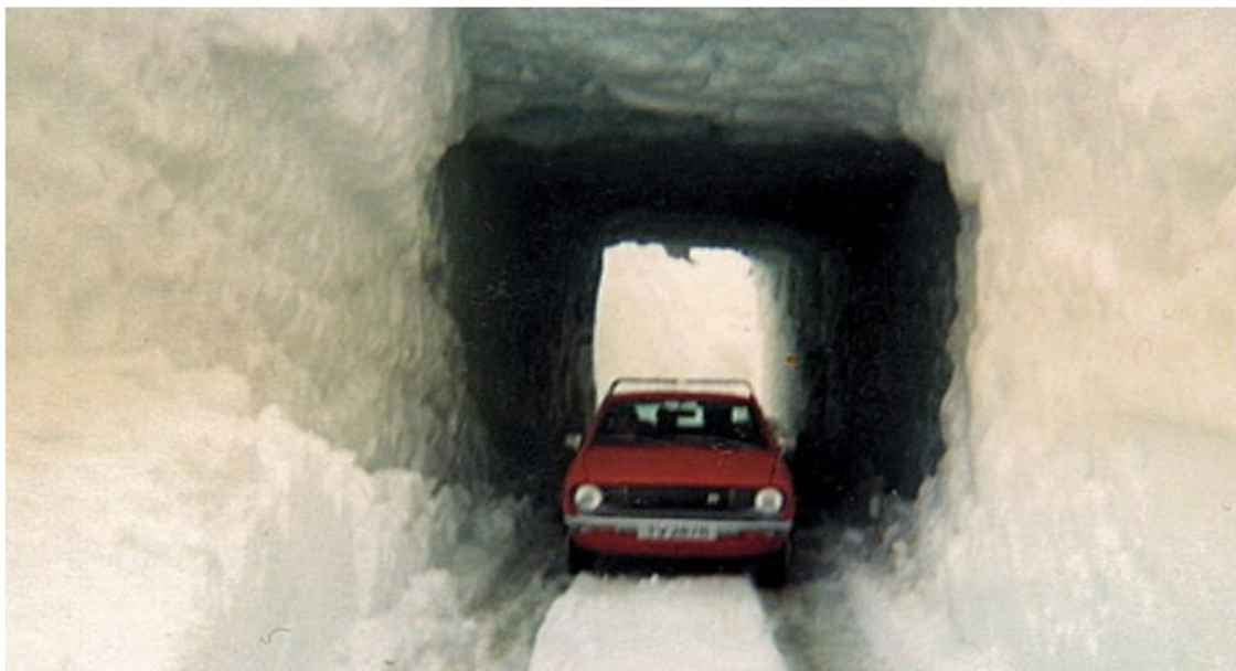
Figur 22 På 1970-tallet ble det bygget en snøtunnel for å redusere ryddearbeidet og gjøre det tryggere for ryddemannskapet i Utledøla. Bildet er hentet fra NRK (Uglum, 2008).
