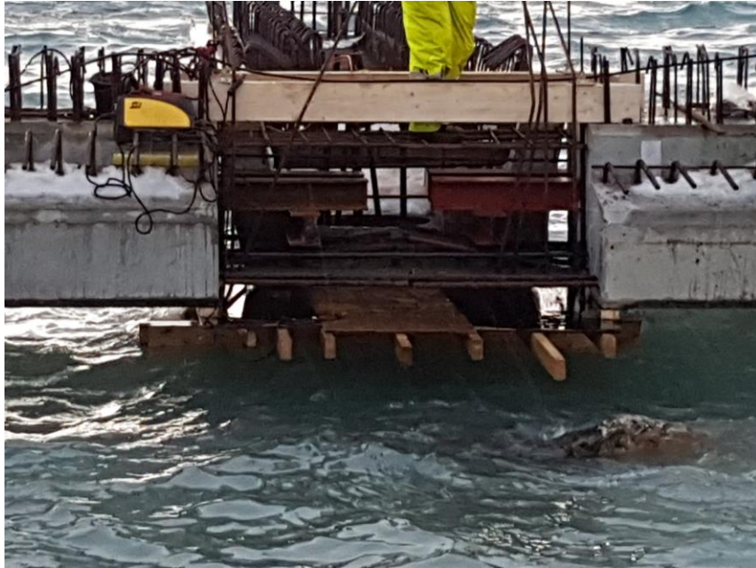
Figur 23 Bakbjelker og hovedbjelke, forskaling (Vannavalen)
