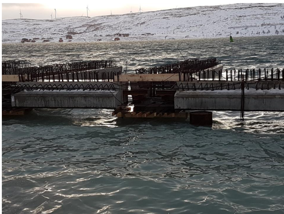
Figur 11 Bakkjelker og hovedbjelke under pågående forskaling (Vannavalen)
