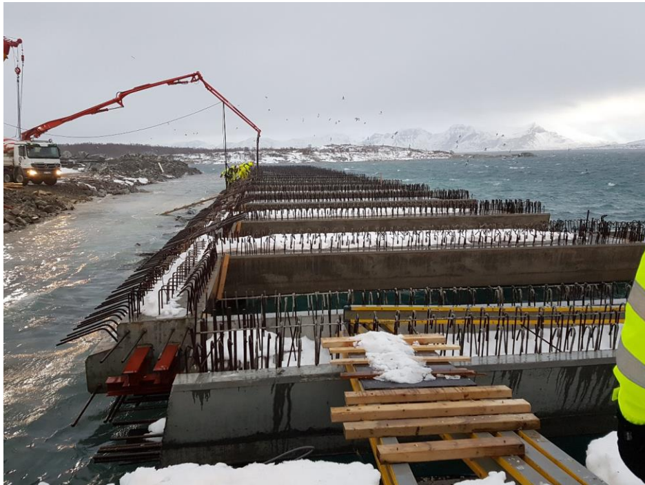
Figur 9 Pågående støping av sammenføyinger av hovedbjelke og bakbjelke (Vannavalen)
