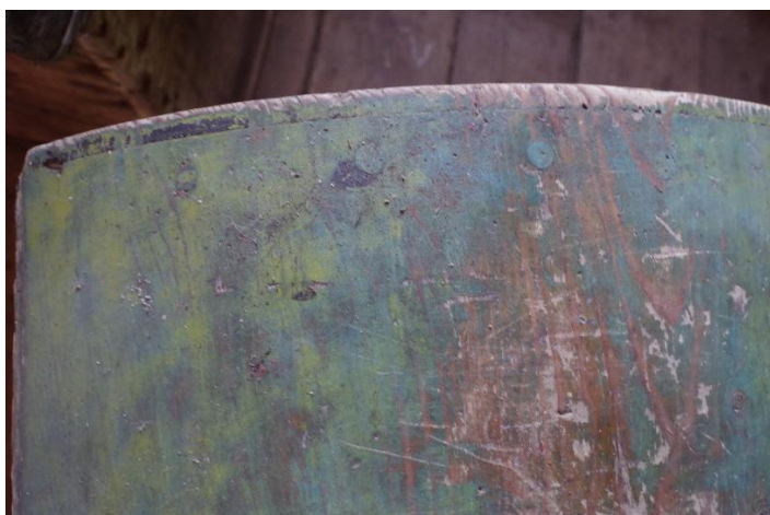
Figur 39: lokkets overside med synlige spiker.
