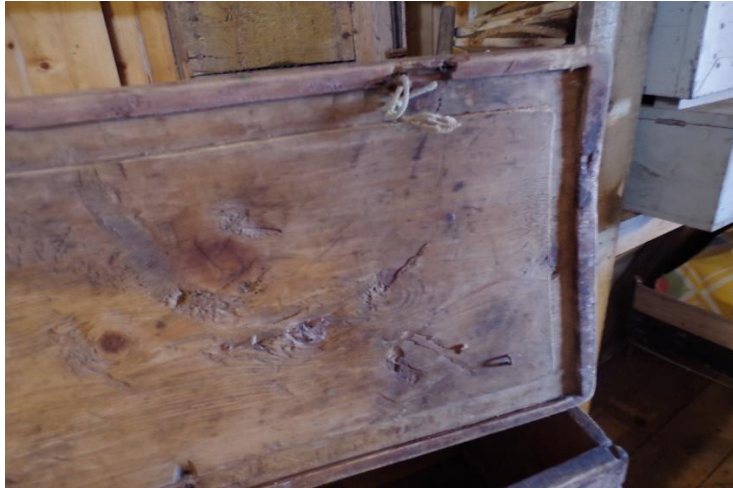
Figur 54: Til høyre: Innsiden av lokket med trådfeste øverst.
