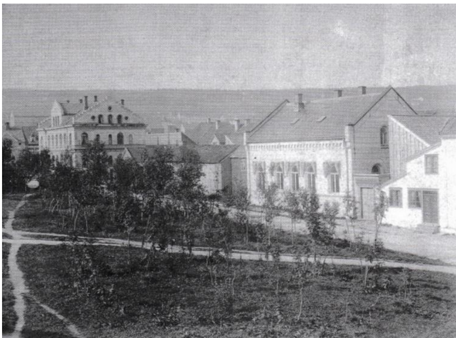
Figur 25: Nordre Kirkegate (Bankgata) med en del av Kirkegata som ble opparbeidet i 1890. «Badet» ble oppført i 1893. Foto: Jørgen Wickstrøm, Tromsø. R. Eilertsen 1978 s. 91.
