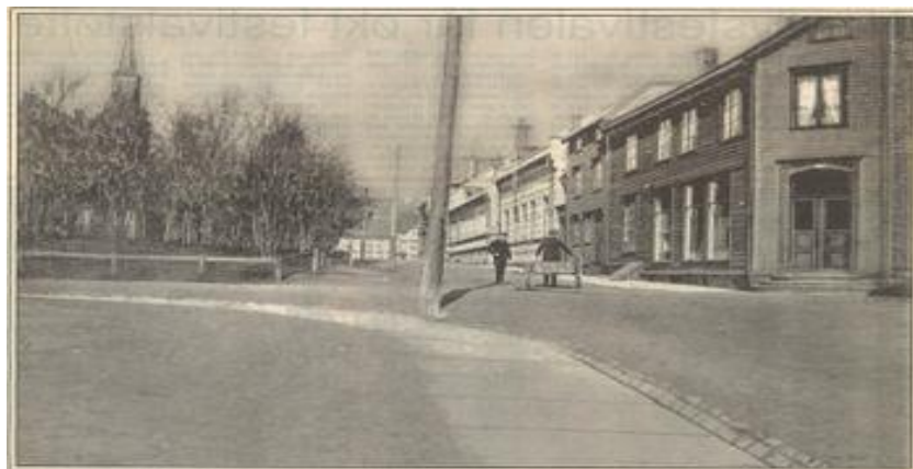
Figur 21: Bankgata 5, ny bygning ca 1900, Tidligere skole fra 1817, en toetasjes trebygning med torvtak. Tromsø kommunes fotoarkiv.
