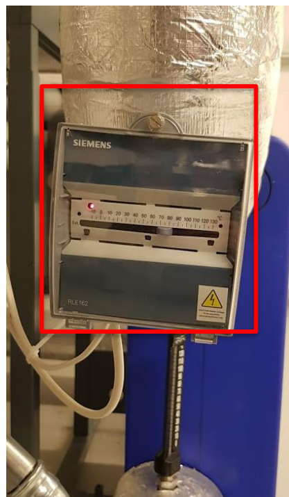
Figur 34 - Temperaturregulator i system 320.01 med settpunkt 75°C.
