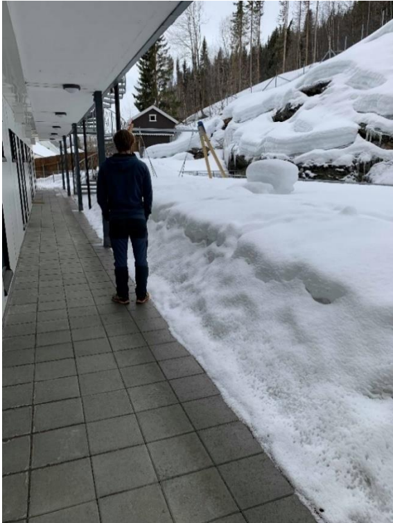
Figur 7.24. Mengden snø som blir lagret opp på terrassen. Under snøen ligger terrassebord og drenering med lokalt fall mot sluk (Foto: Emil Pettersen).
