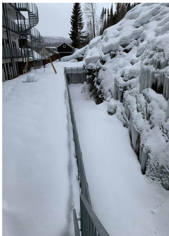
Figur 4.10. Viser baksiden av Øvreveien terrasse som vender mot fjellsiden. På bildet kan man se store mengder snø og is på fjellsiden. (Foto: Emil Pettersen)
