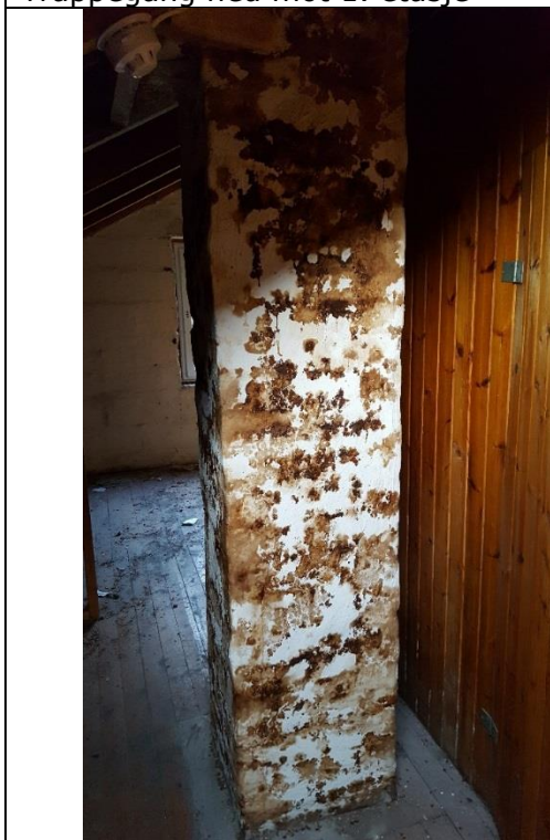
Bilde nr. 13 Pipeløp med tydelig gjennomslag av tjære.
