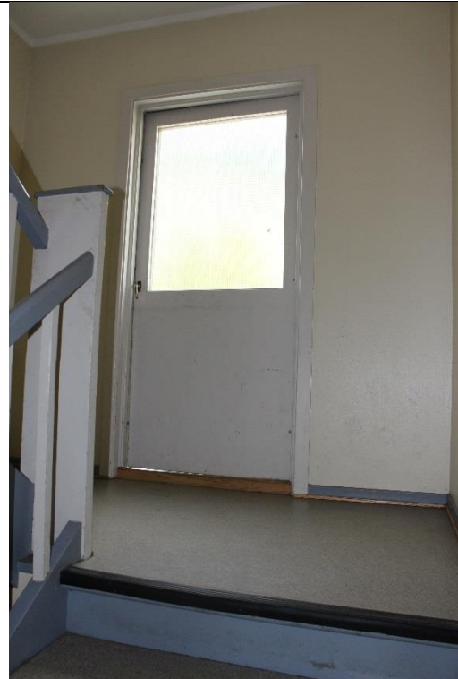
Bilde nr. 12 Trappegang mot balkongdør
