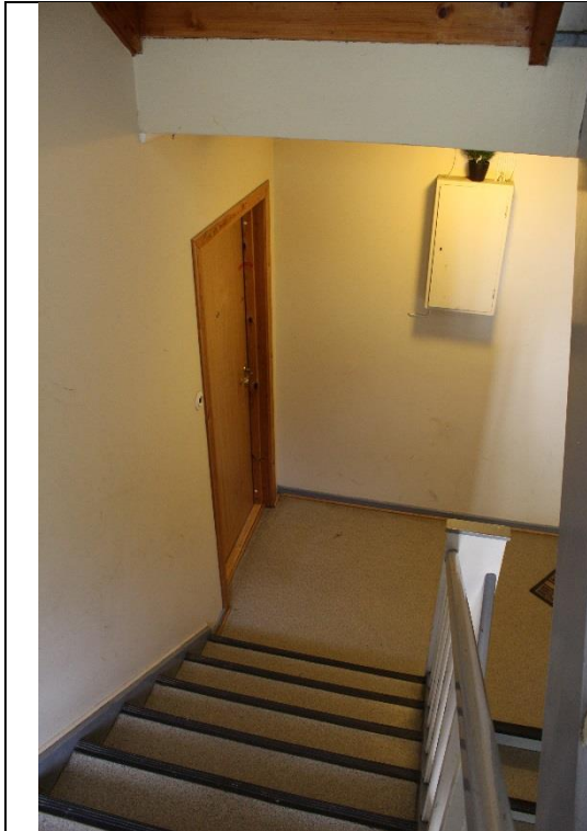
Bilde nr. 11 Trappegang ned mot 1. etasje
