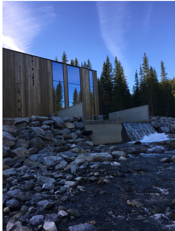
Figur 23: Tverrå kraftverk i Brønnøy kommune
