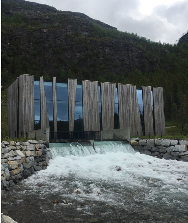
Figur 21: Prisbelønte Øvre Forsland kraftverk
