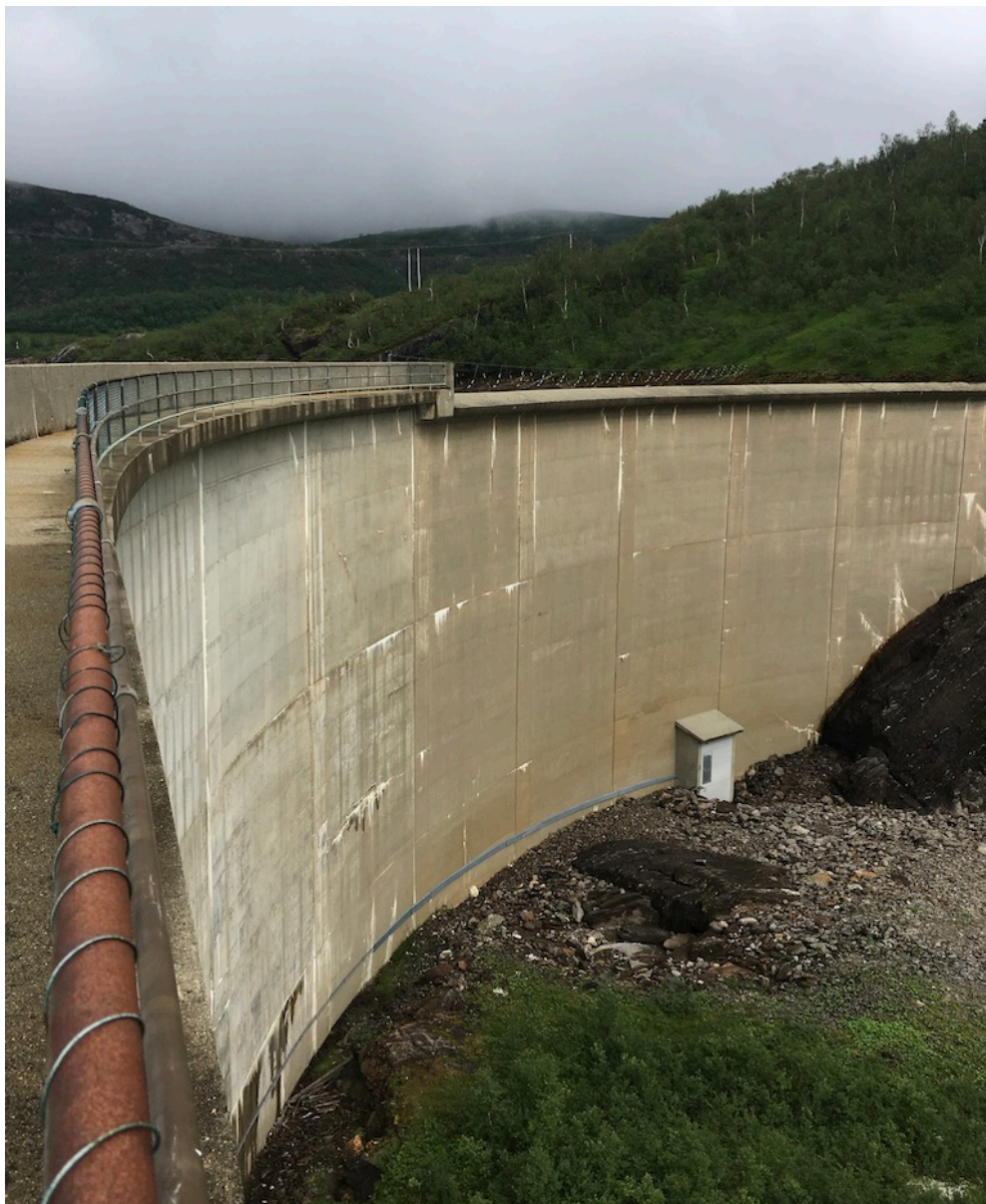
Figur 25: Enkeltkrum hvelvdam på Fagervollan som demmer opp Holmvatnet og Nedre Fagervollvatnet for kraftproduksjon i Sjona kraftverk.
