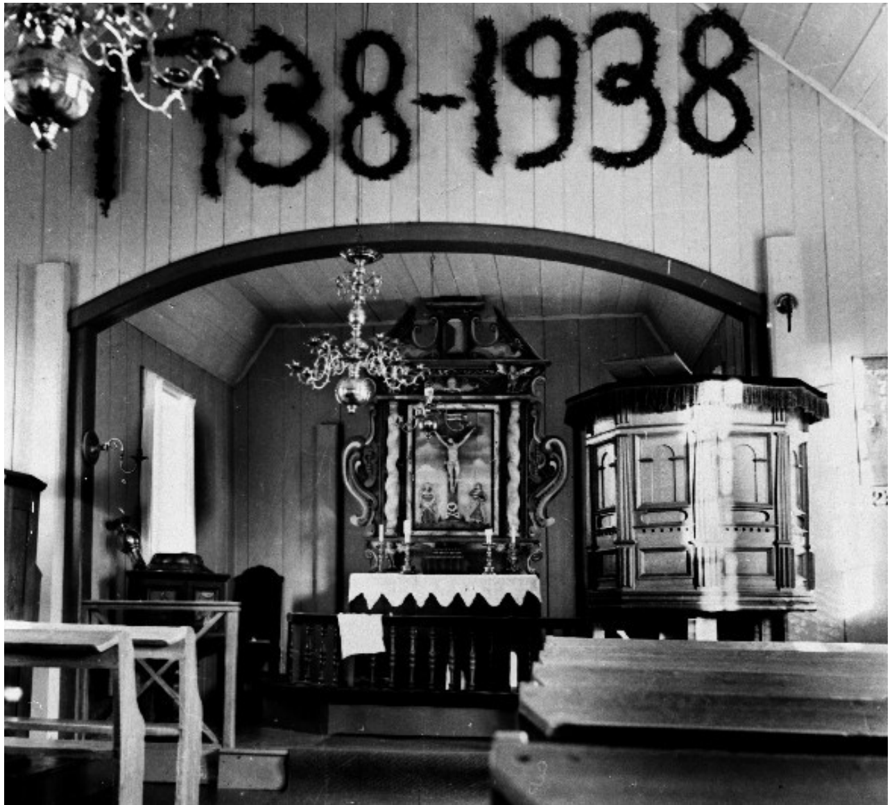
Kjøllefjord 2, interiør under jubileumsfeiringen i 1938. Himlingen må være sekundær i forhold til Nannestads beskrivelse (se "bygningshistorie"), og er tydeligvis kledd på undersiden av sperrene og en (nedre) hanebjelke i en sperretakskonstruksjon. Altertavlen var opprinnelig fra Omgang kirke, produsert i 1662, og kom til Kjøllefjord sammen med en del andre inventarstykker fra Omgang i 1775. Foto: Elisabeth Meyer, 1938. I privat eie hos Harald Babala, utlånt til billedsamlingen ved Fylkesbiblioteket i Finnmark.
