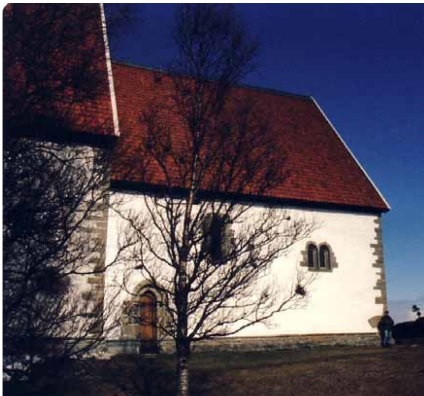
Trondenes kirke, koret sett fra sør i 1995. Foto: V. Trædal.
