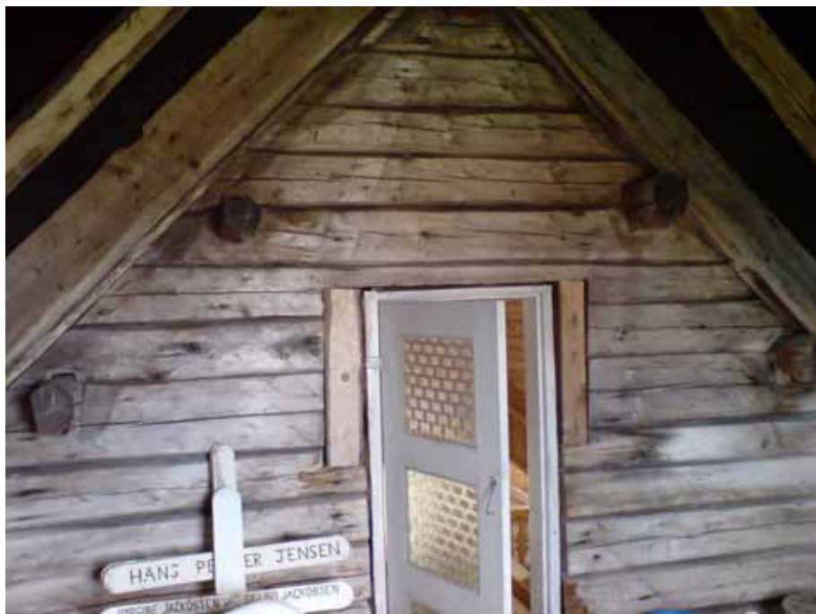
Tranøy kirke, 22. mai 2007. Bygningsdetaljer: Kirkens vestre gavlfot, fotografert fra det nyere tårnet. Kirkens takåser laftet inn i gavlveggen. Nyere dør der hvor kirken tidligere har hatt et gavlvindu. Foto: Vidar Trædal.
