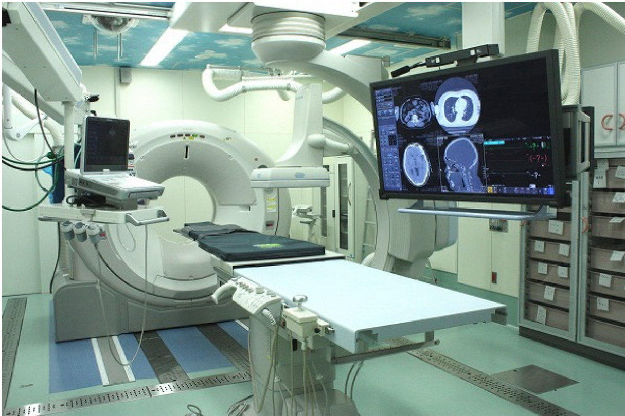
Bilde 4 Akuttstue med CT/angio/operasjon for mottak av traumepasienter ved Osaka General Medical Center i Japan
