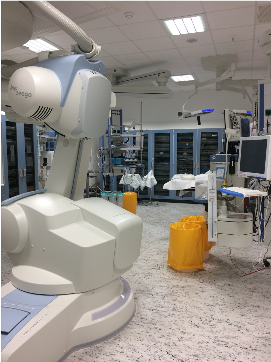
Bilde 3 Hybridstue for operasjon/angio ved Ullevål sykehus
