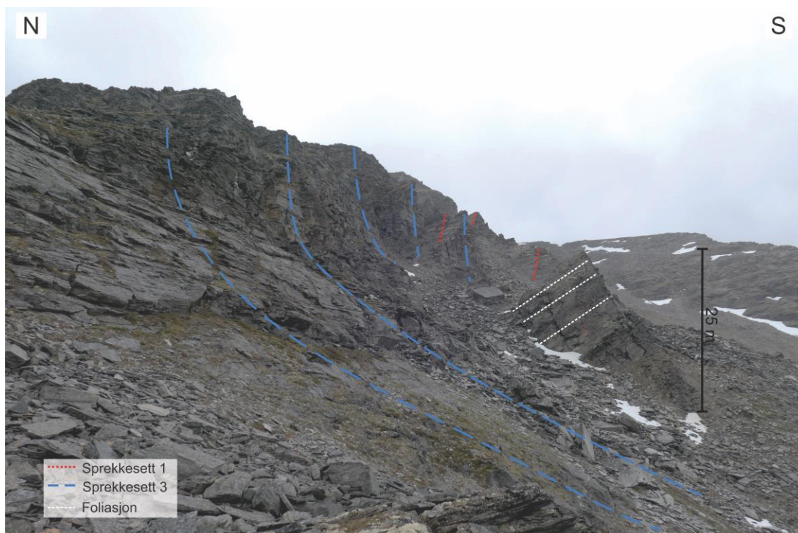
Figur 53: Stor SV orientert skrent sør i skredet. Skrenten viser listrisk geometri, der utrast blokk har foliasjon orientert inn mot skrenten. Sprekkesett 1 vises også som tydelig motstående skrenter.
