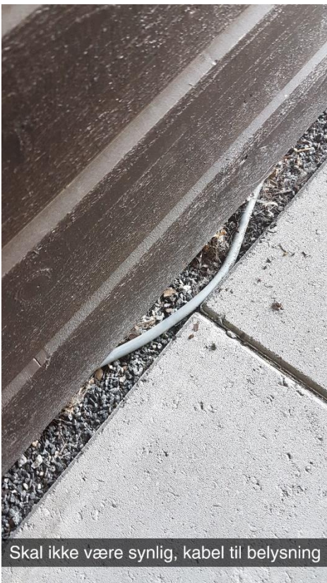
Figur 10. synlig kabel
