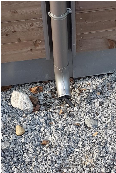
Figur 5. fall fra utløp med frost i bakken
