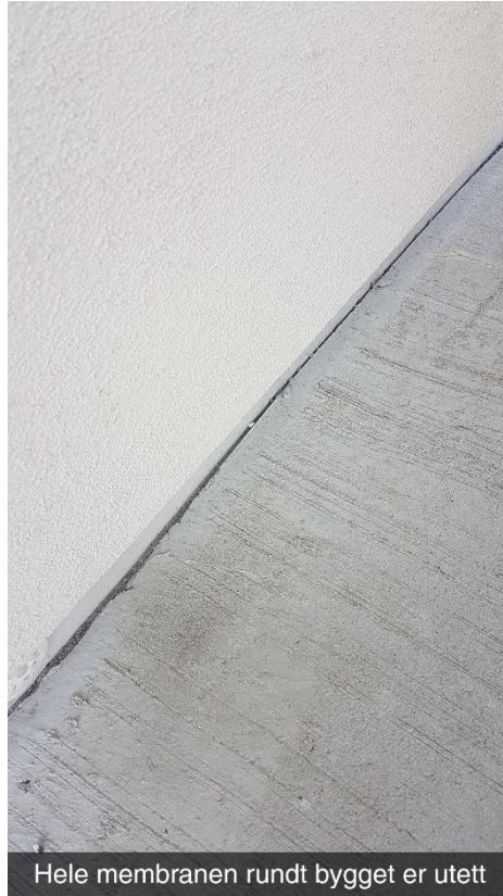
Figur 20. utett membran
