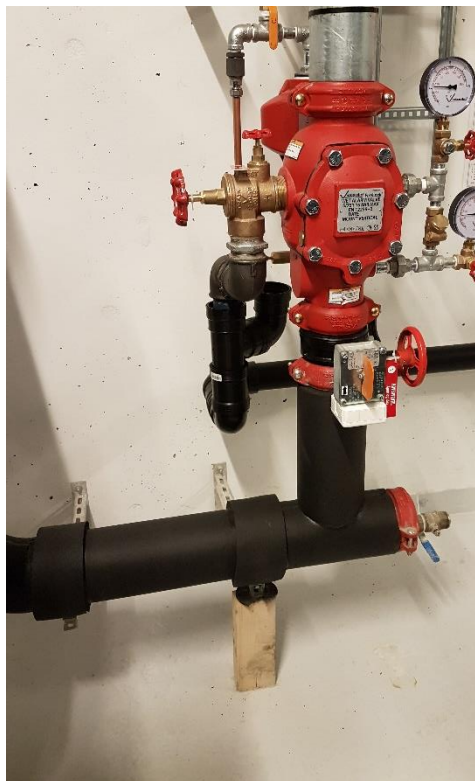
Figur 5. bruk av trekloss
