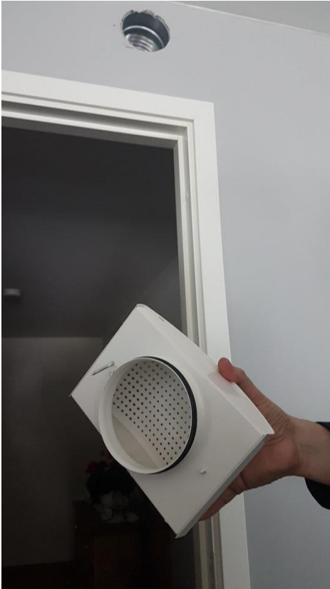
Figur 7. ventilrist ikke festet
