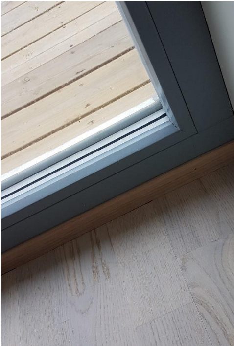
Figur 7. List dekker ikke skjõt
