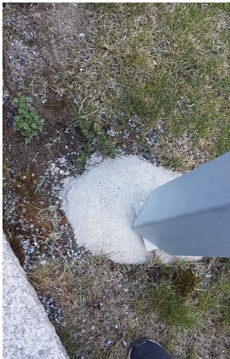
Figur 11. Fundament satt for høyt
