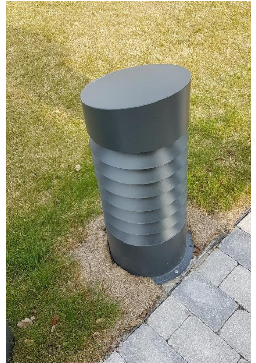
Figur 3. Fundament ligger for høyt
