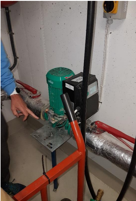
Figur 10. Mye støy fra pumpe, opplegg/innfestning må dempes
