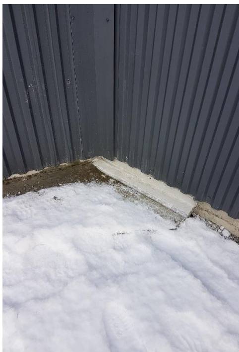
Figur 1. vann trenger inn, tegning ikke fulgt
