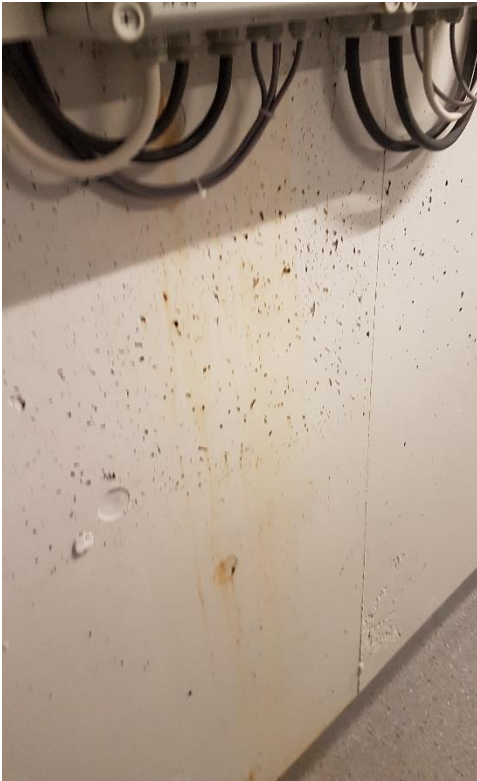
Figur 1: Vannlekkasje kjellervegg
