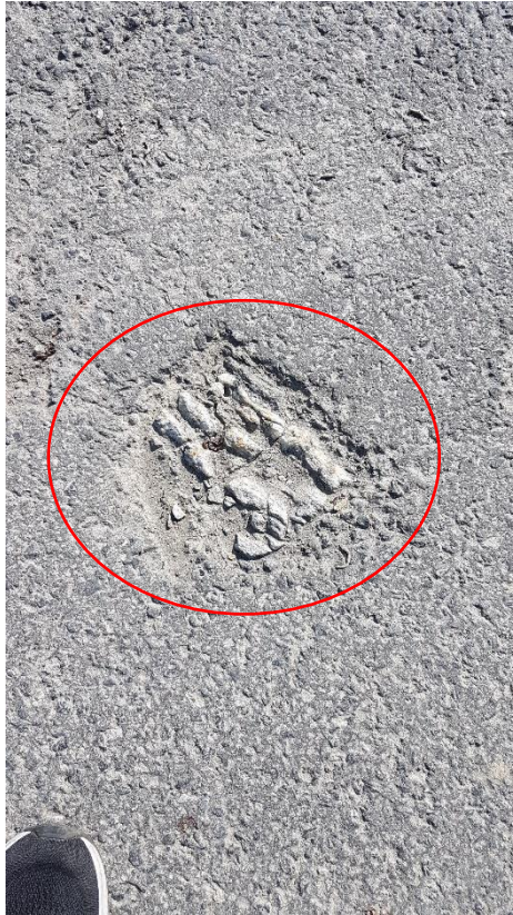
Figur 2. stein i dagens asfalt, for tynn
