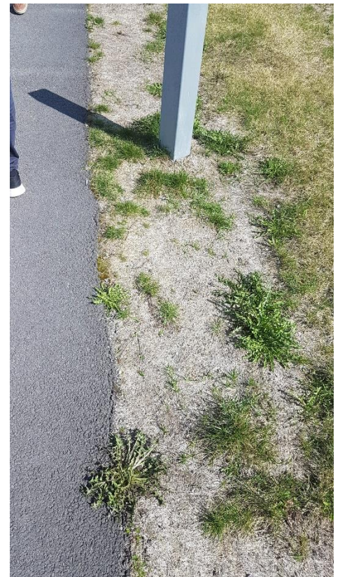
Figur 12. Gressunderlag målt til 30 – 50 mm, gir ikke grønt gress
