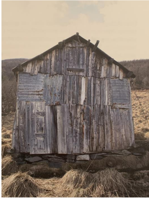
Figur 37: Rognli, Gjert og Ludvig Rognli. « Man tager hva man haver » - et godt eksempel på bruk av tilgjengelige bygningsmaterialer. 2013. Foto. Várit Leat Seammat : Jávkamin Mearrasámi Kultuvrra Govat = Men Fjellan E De Samme : Fotografier Fra En Utdøende Kystkultur s. 85. © Gjert Rognli og Ludvig Rognli. Skannet fra privat fotobok.
