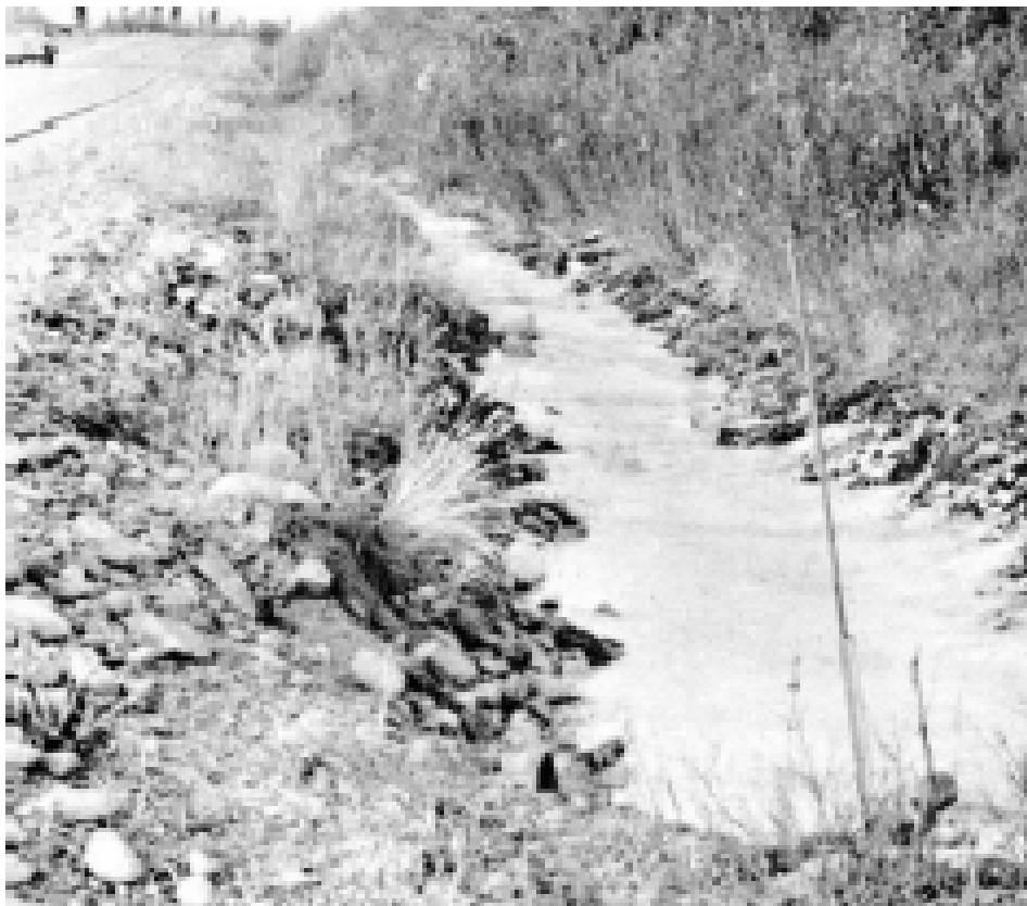
Figur 16. Lav vintervannsføring som har medført iskjøving (Carey, 1973)
