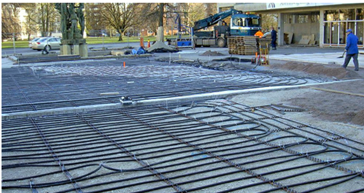
Figur 41. Eksempel på sløyfelegging fra gatevarme som prinsipp, permanent system (LK Systems AS, 2022)
