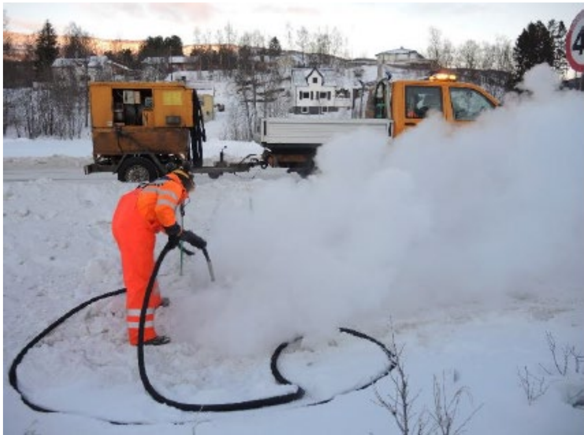
Figur 38. Tining med steam (Statens Vegvesen, 2017)
