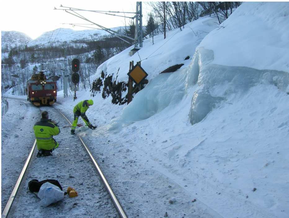
Figur 14. Iskjøving på grunn av vann fra overliggende terreng og fra bergsprekker på Ofofbanen Foto: Knut Karlsen, JBV/Bane NOR
