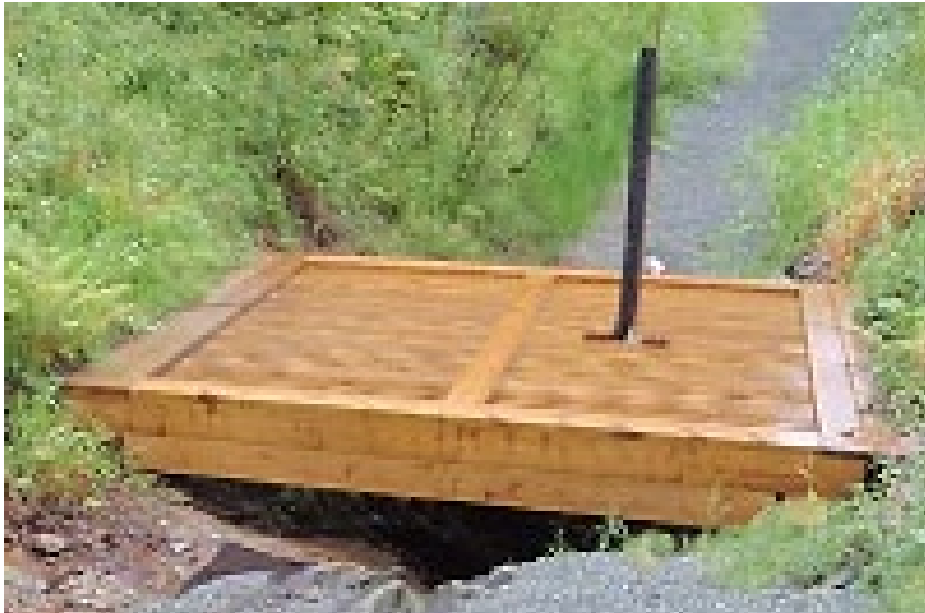
Figur 29. Svillelokk / tredekke over innløp til stikkrenne med føringsrør for steamslange Foto: Bane NOR
