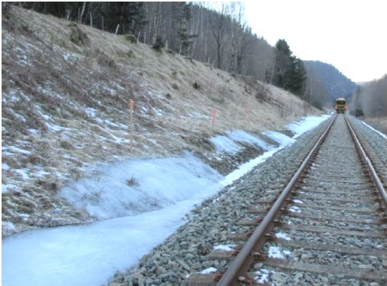
Figur 15. Iskjøving "oppstrøms" fra grøft normalt på veg/jernbanekroppen (Liereng, 2016)
