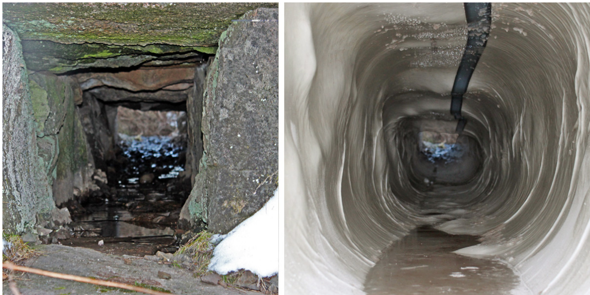
Figur 19. Steinkiste som ikke er renoveret og steinkiste som har vært renoveret (Bane NOR SF, 27.04.2022)
