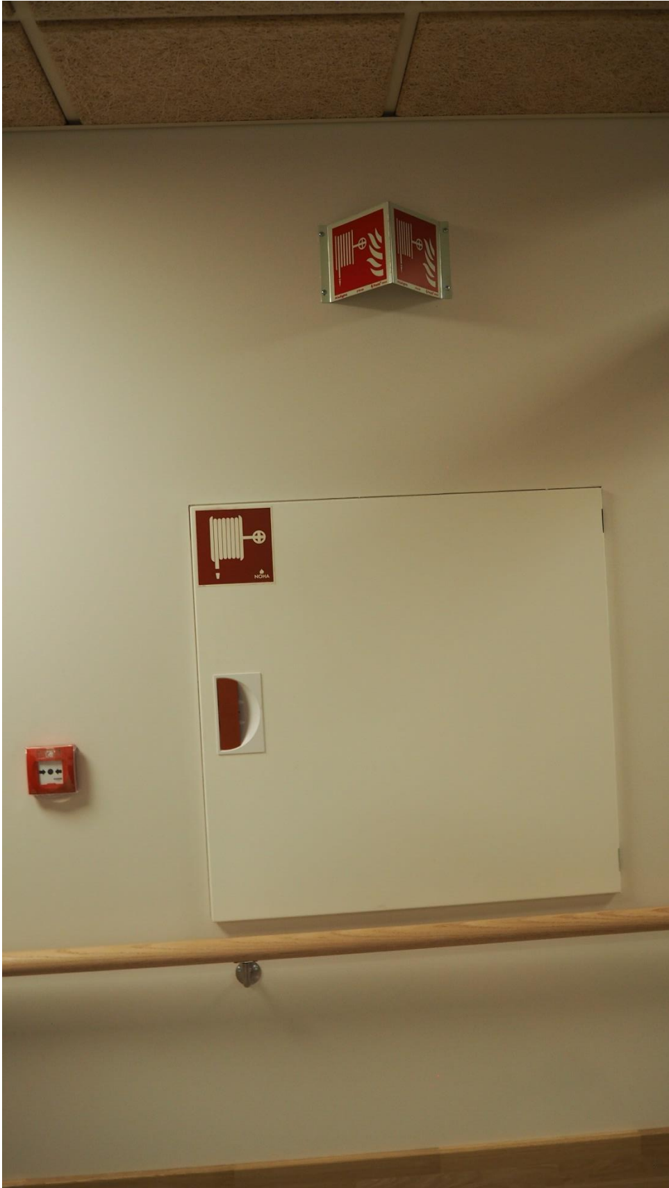
331 Installasjon for manuell brannsløkking med vann
