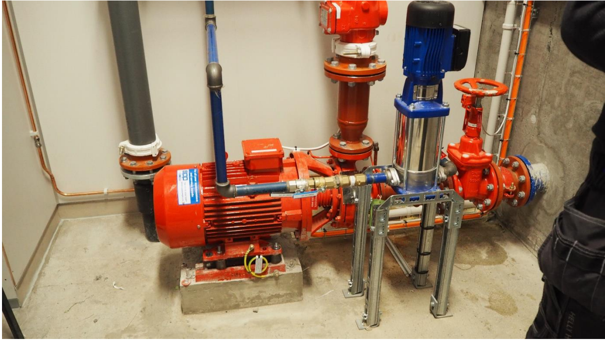
332 Installasjon for brannsløkkig med sprinkler
