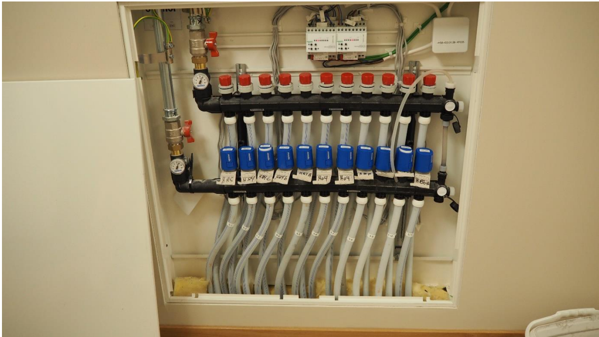
322 Ledningsnett for varminstallasjoner
