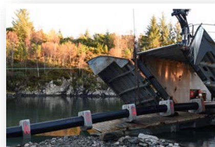
Figur 31 - senking av undervannsledning (Hallingplast AS)
