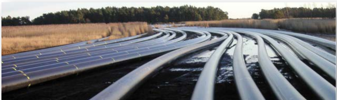
Figur 14 - PE rør klar for leveranse
