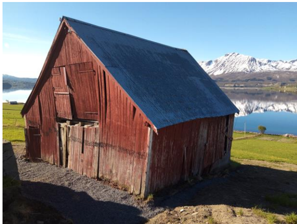
Figur 3. Fjøs under restaurering. Her er gjort grunnarbeid i form av drenering. Foto: privat
