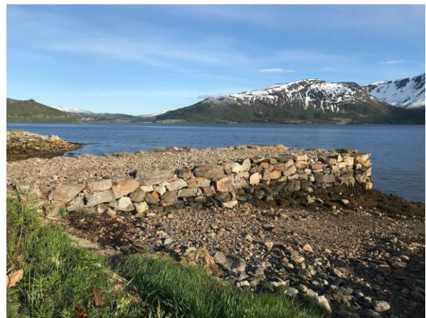
Figur 6. Drevlandkaia ferdig restaurert. Foto: Ståle Størkersen
