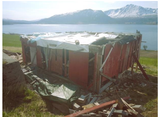
Figur 4. Fjøs under restaurering. Fjøset har blitt jekket opp og skal få nytt tak. Foto: privat
