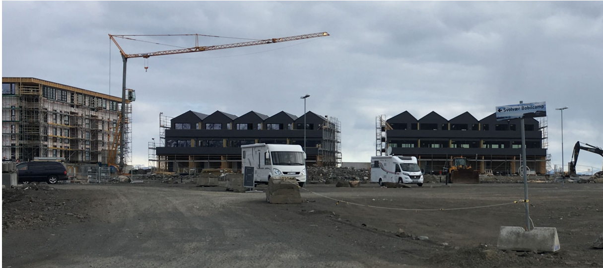
Bilde 6. Vårsetøya er en bobilparkering i påvente av et nytt leilighetskompleks
