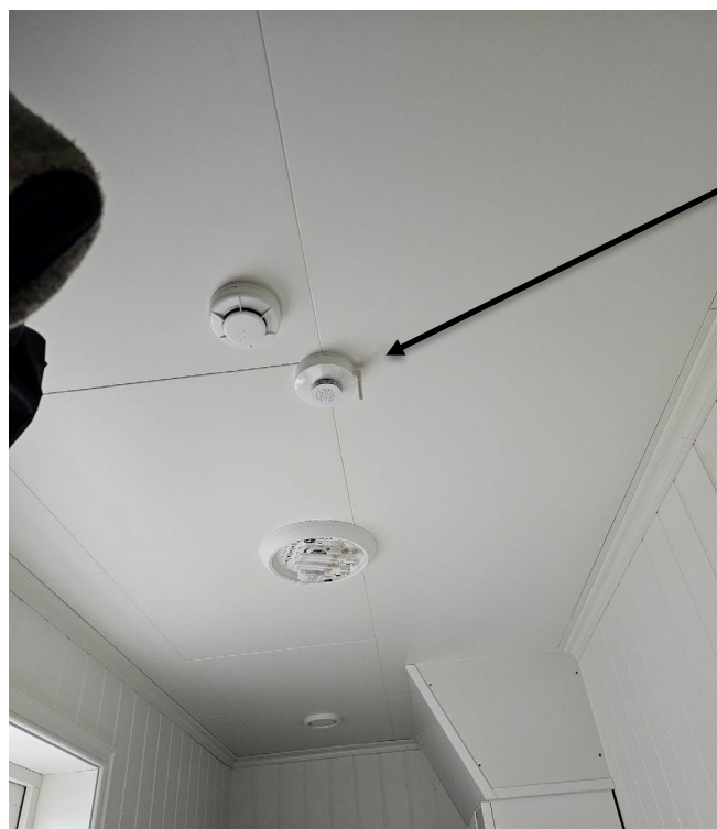
Figur 8 Plassering av klimasensor i bolighus, Tak i stue (Øverst), Tak i teknisk rom (Nederst)
