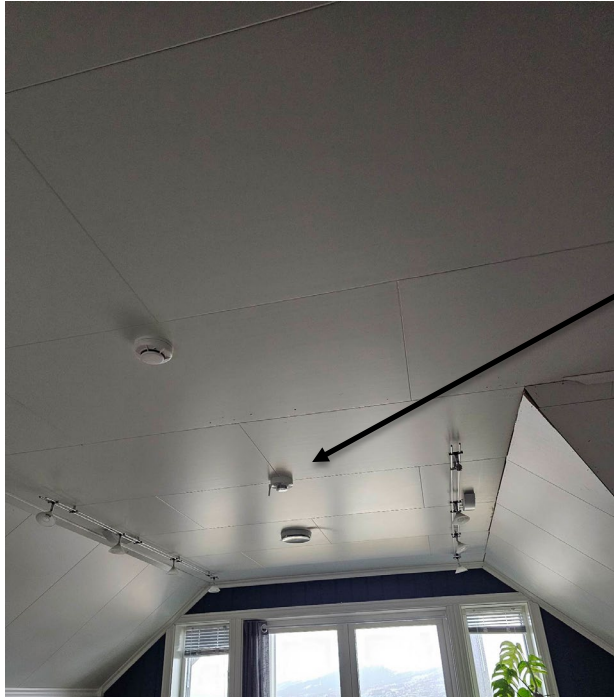
Figur 9 Plassering av klimasensor i bolighus, loftstue
