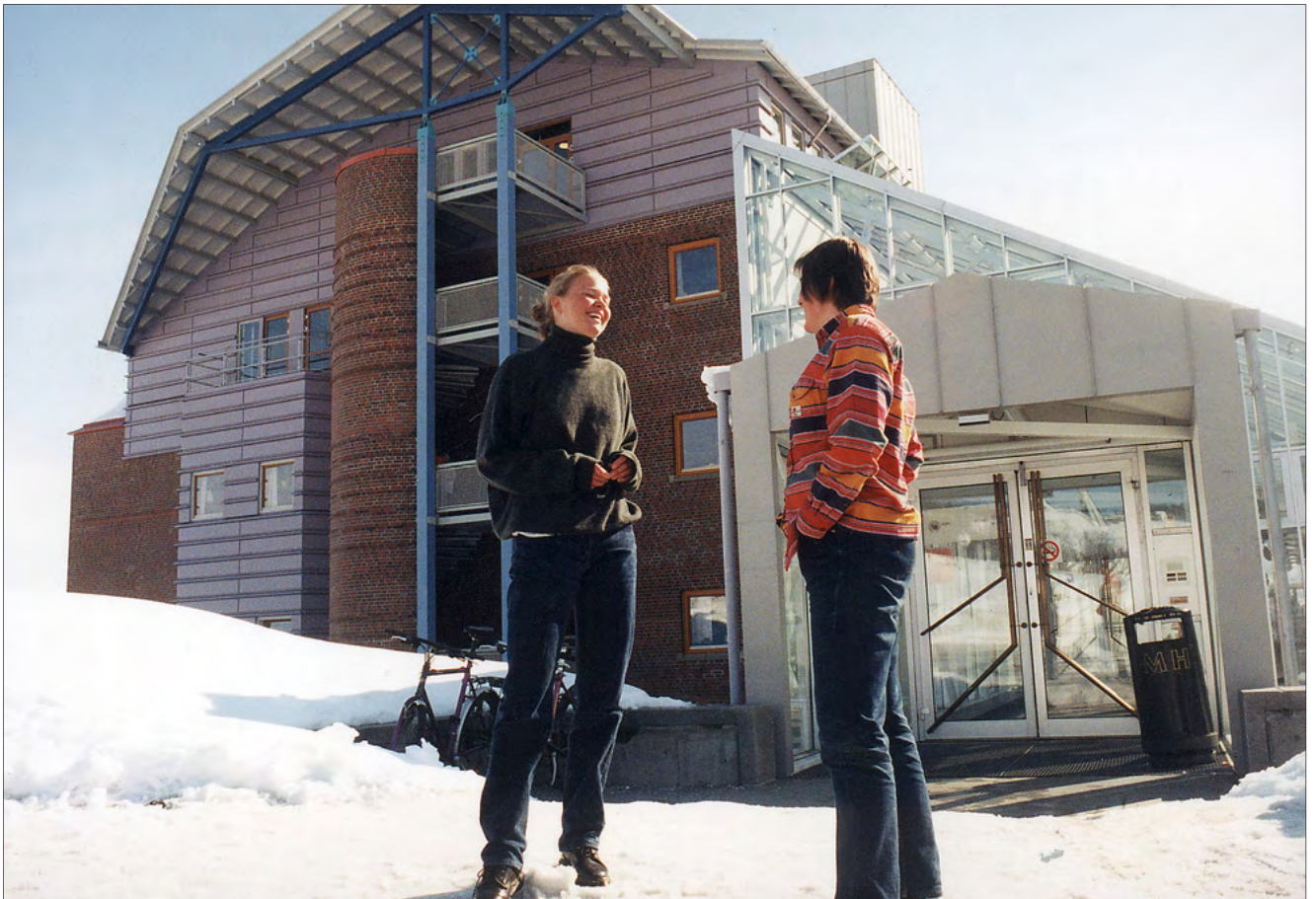
Inngangspartiet til medisins- og helsefagbygget (MH-bygget) i Breivika, hvor Avdeling for helsefag har holdt til siden oppstart i 1994.
