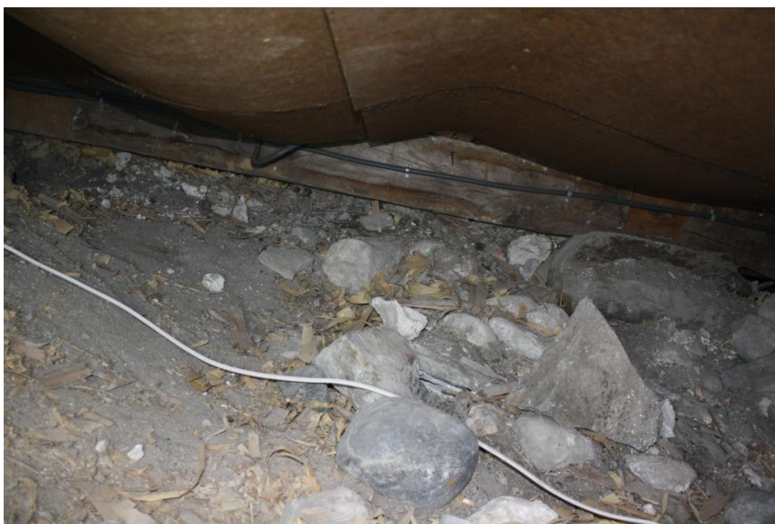
Figur 15: Den østre kanten av fundament K1 (se figur 17). Foto: V. Trædal 22.02.09
