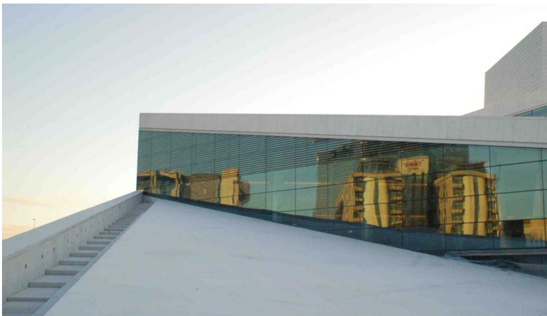
III. 4 Operabygningens glassvegg mot nord speiler den nye bybebyggelsen i Bjørvika. I øvre glassfelt er sørveggen solcellemønster brukt som dekorativt element.
