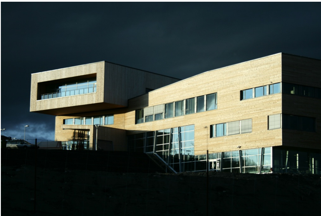
Ill. 8. Diehtosiida, Samisk vitenskapsbygg i Kautokeino (2009), etter arkitektkonkurranse vunnet av Reiulf Ramstad arkitekter. Foto: Tone Thørring Tingvoll 2010.
