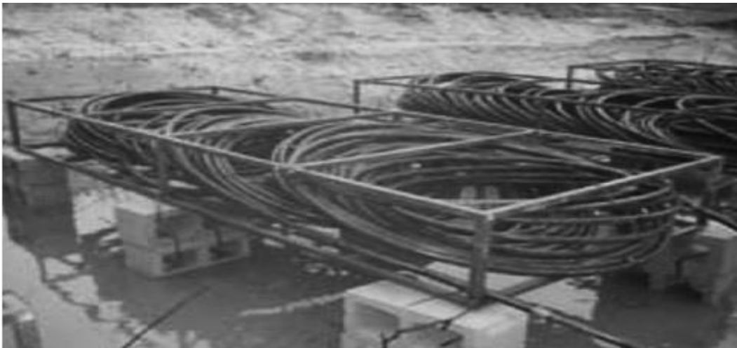
Figur 6: Et forankret slinky system før utplassering i innsjø [Banks, 2012]
