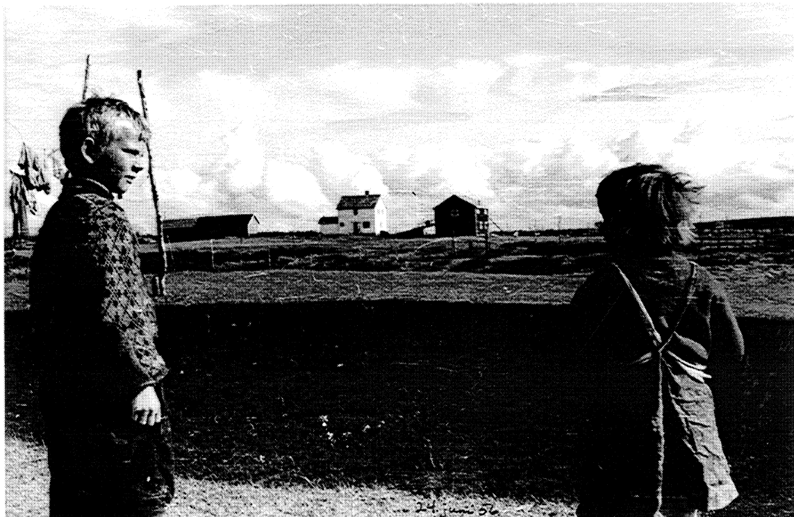
Bilde 37. Johan M. Klemetsens bruk sett fra Daniel M. Hætta hus. Den nye gården, reist i 1950, et toetasjes hus, 9 m x 9 med anneks 4 m x 3,5, fjøs med låvebru, krambu og stabbur, ble bygget oppe på bakken, vel 100 m fra elva og den gamle gården. Mathis Klemetsen Hætta's gamle gård var stor i forhold til datidens standard. Derfor var også krigserstatningen en av de største i kommunen. Midtveis mellom Johan Mathis og Daniel sitt hus er tuftene til det første huset i Siebe, det tilhørte Anders Larsen Bær, fra 1840-årene. Dette bildet er tatt St. Hans 1956. Til venstre står Johan Daniel og til høyre Brita Ellen Marie.
